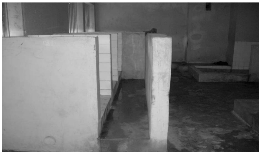
Photo 1 : Vue des sanitaires (latrines et douche) adjacentes aux cellules d'enfermement.
