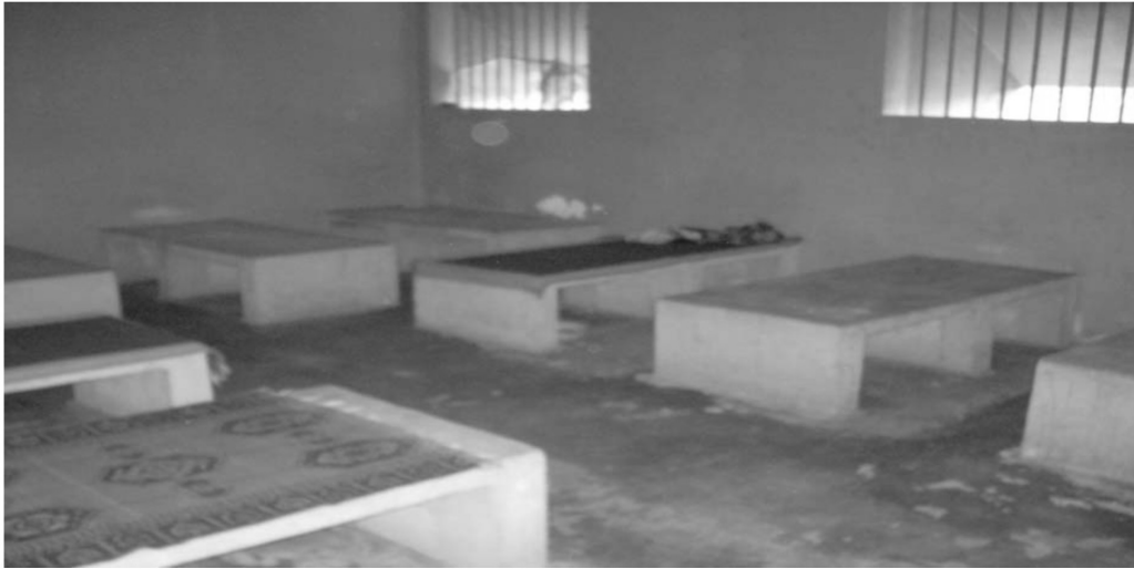
Photo 2 : Vue d'une cellule d'enfermement avec lieux de couchage en béton.
