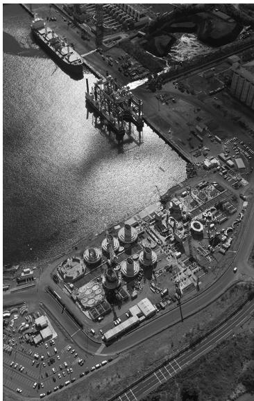
Figure 1a : Vue aérienne Préfa Appuis (Crédits photos : Viaduc Littoral / Sébastien Marchal)
