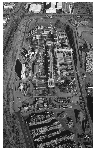
Figure 1b : Vue aérienne Préfa Voussoirs (Crédits photos : Viaduc Littoral / Sébastien Marchal)
