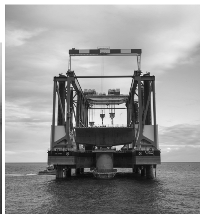
Figure 1c : Méga-barge « Zourite » utilisée pour l'installation des piles de pont (Crédits photos : Viaduc Littoral / Sébastien Marchal)
