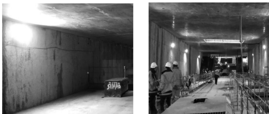
Figure 5. Paroi moulée de la station de métro
