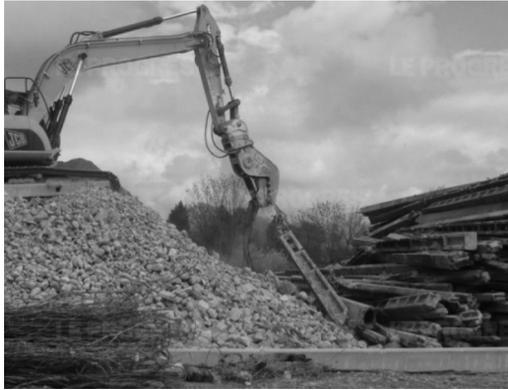
La société CMEG (Normandie) utilise des granulats issus du recyclage des bétons des poteaux électriques pour réaliser des murs à coffrage intégré.
