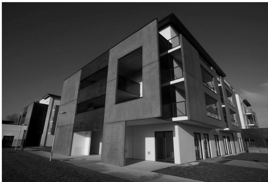
**Ouvrage réalisé à partir de produit préfabriqués incorporant des granulats recyclés - CMEG**
