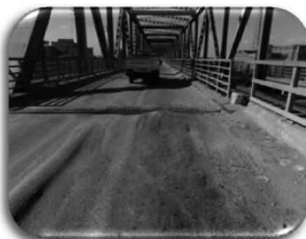
Figure 10 : Etanchéité inefficace sous dalle.
