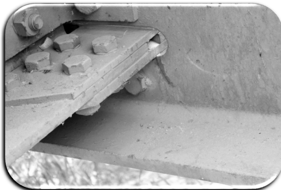
Figure 16 : Amorce d'une rupture à la fatigue d'une attache longeron/pièce de pont.
