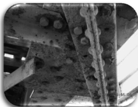
Figure 9 : Corrosion sévère d'une attache.
