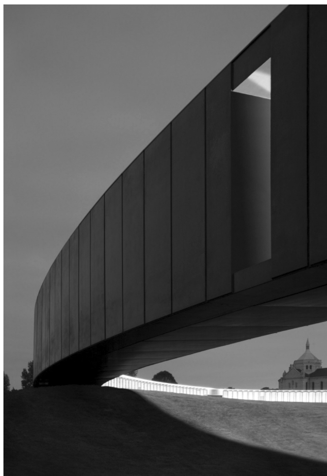
Photo 3 : Vue de la zone précontrainte en porte-à-faux © Agence Prost.
