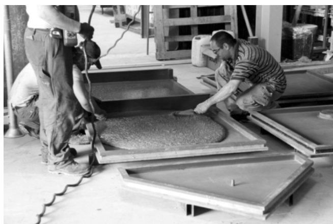
Photo 4 : Bétonnage des dalles de sol en BSI® © H. Abaddie.
