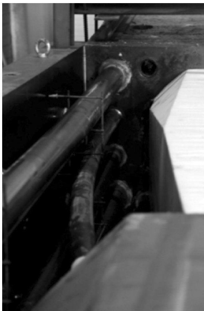
Photo 7 : Gains de précontrainte en position dans le moule © H. Abbadie.
