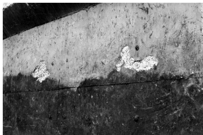
Figure 14 : Parement du piédroit côté remblai après décapage des terres.
