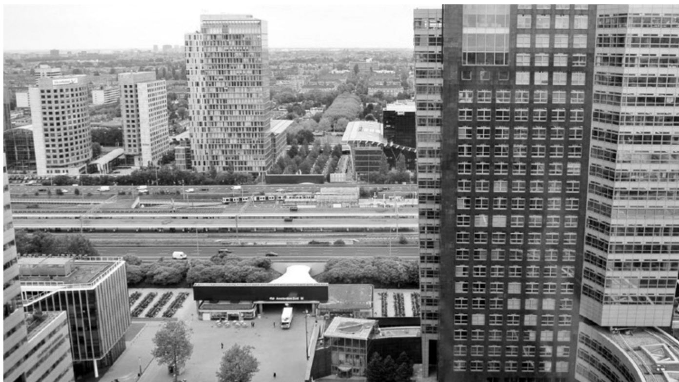
Figure 2 : le site de « Zuidas », au Sud d'Amsterdam. Figure 2: « Zuidas », South Amsterdam.
