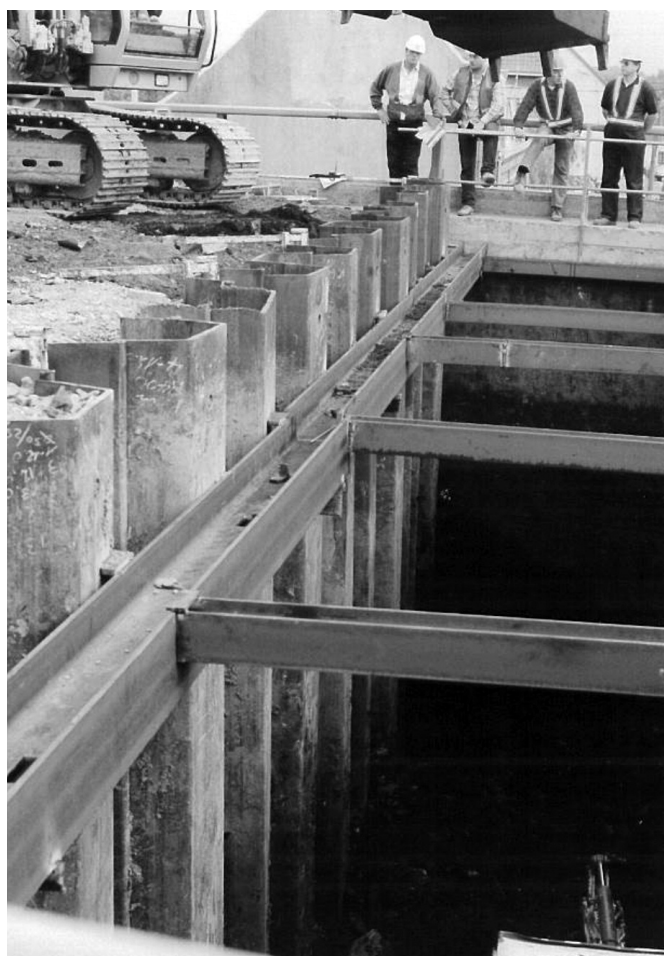
Figure 12 : Rideau de palplanches à l'arrière du piédroit.
