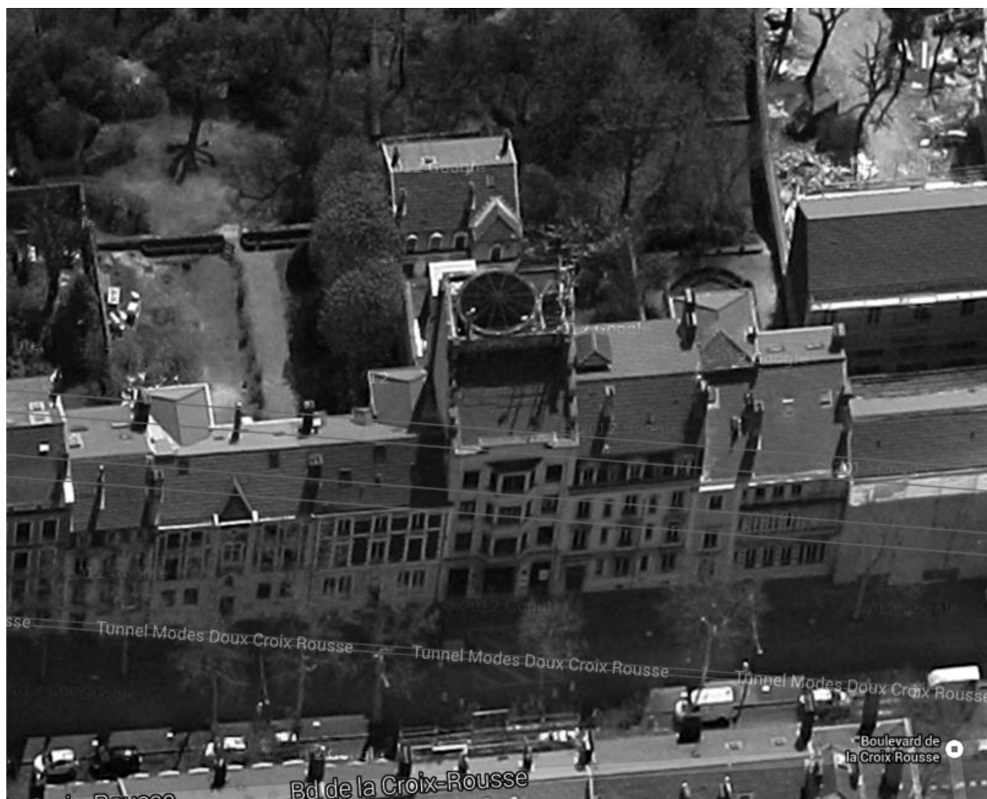
Figure 19 : cheminée de ventilation du Tunnel sous la Croix-Rousse à Lyon. Figure 19: ventilation shaft from Croix-Rousse tunnel in Lyon.
