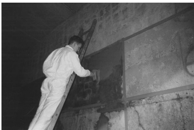
Figure 15 : Application d'un liant hydraulique modifié sur une zone test du PI 328.
