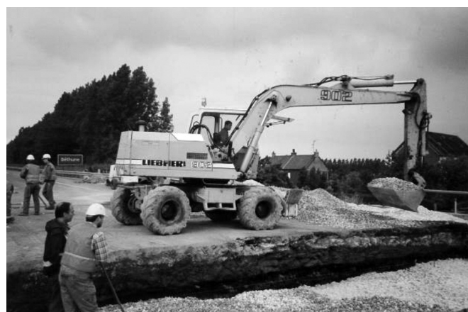
Figure 13 : Retrait du remblai à la pelle mécanique.
