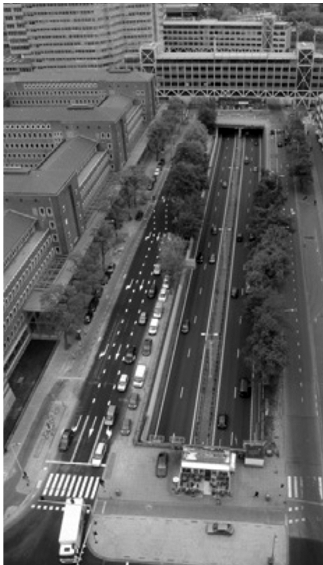
Figure 1 : couverture de l'A12 à la Haye. Figure 1: A12 cover - Den Hagen.
