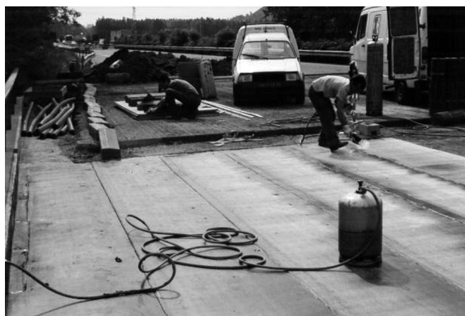
Figure 9 : Réfection de l'étanchéité du tablier du PI 328.
