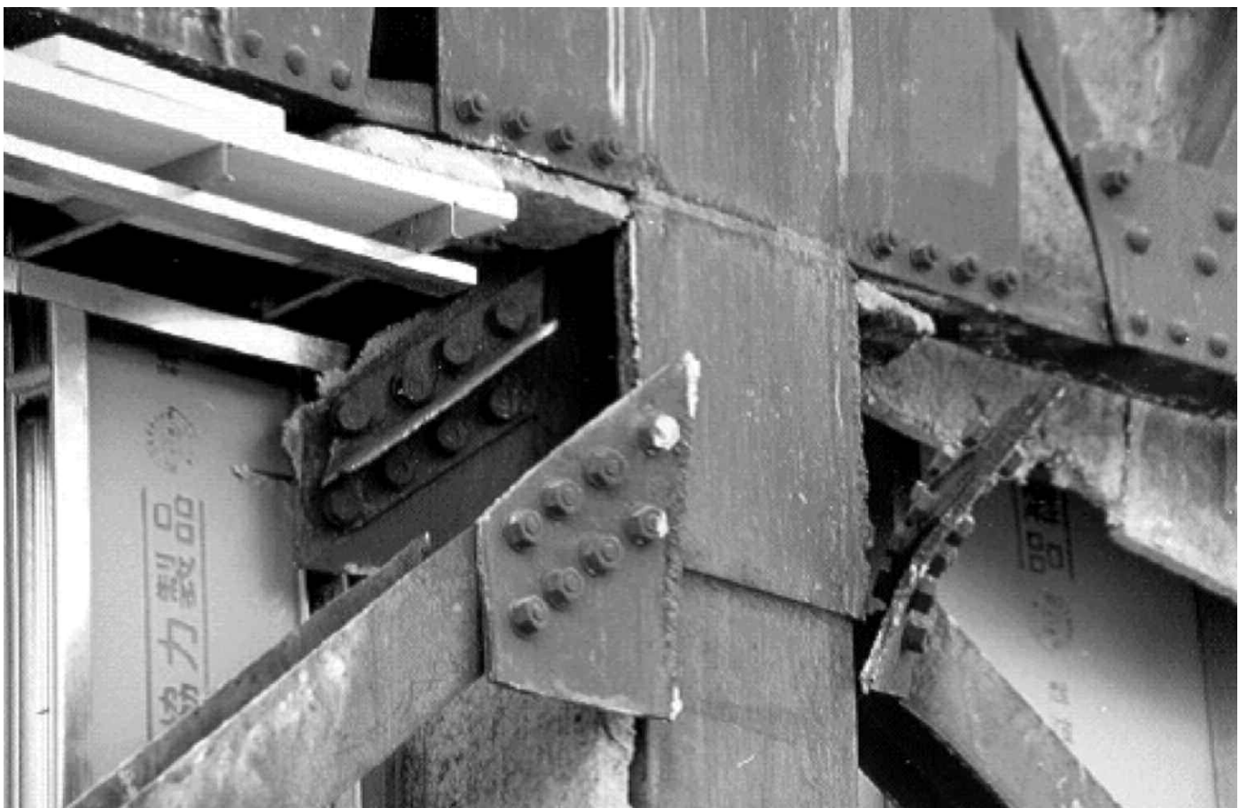
Rupture des éléments non ductile (contreventement en X), séisme de Kobe.
