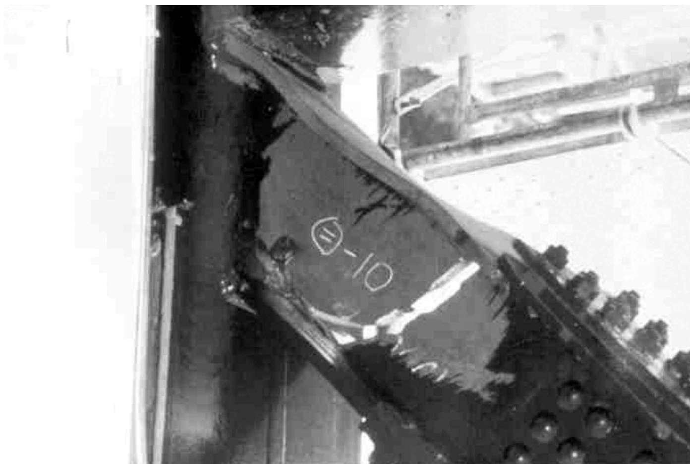
Rupture des soudures de l'assemblage et voilement important des barres (Ashiyahama Complexe), séisme de Kobe.
