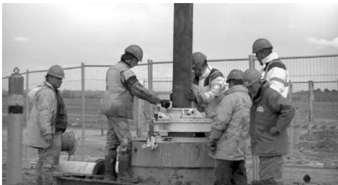
Fig. 7. Mise en place d'un poteau par les ouvriers, avec l'aide du dispositif de centrage, juste après le coulage du béton dans le pieu (juillet 2012). Setting up of the steel column by the workers, just after pouring the concrete in the pile (July 2012)
