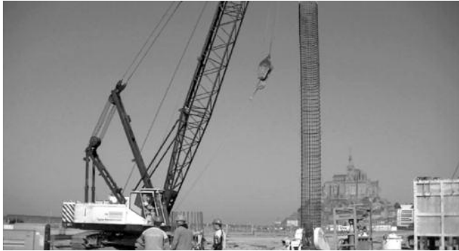
Fig. 5. Mise en place de la cage d'armature du pieu, après tubage et forage (juillet 2012). Setting up of the reinforcement cage of the pile, after boring and setting up of the tube (July 2012)
