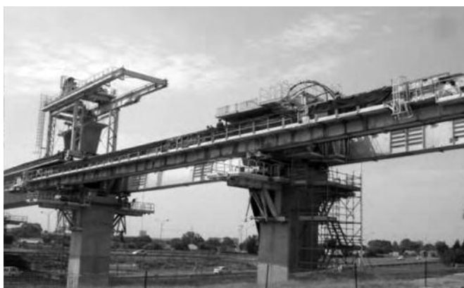
Photo 11 : Lanceur type T2/ Launcher T2.
