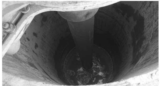
Fig. 8. Poteau dans le tubage, en attente de la prise du béton du pieu, 7m sous le niveau du terrain naturel (juillet 2012). Steel column in the tube, waiting for the hardening of the concrete of the pile, 7m below the ground level (July 2012)
