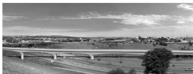
Photo 3 : Viaduc 05d construit par encorbellement avec voussoirs coulés en place / Cast in situ concrete cantilever viaduct 05d.
