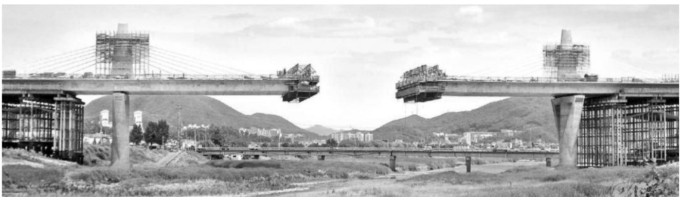
Pier 10: Construction par encorbellement / Cantilever construction
