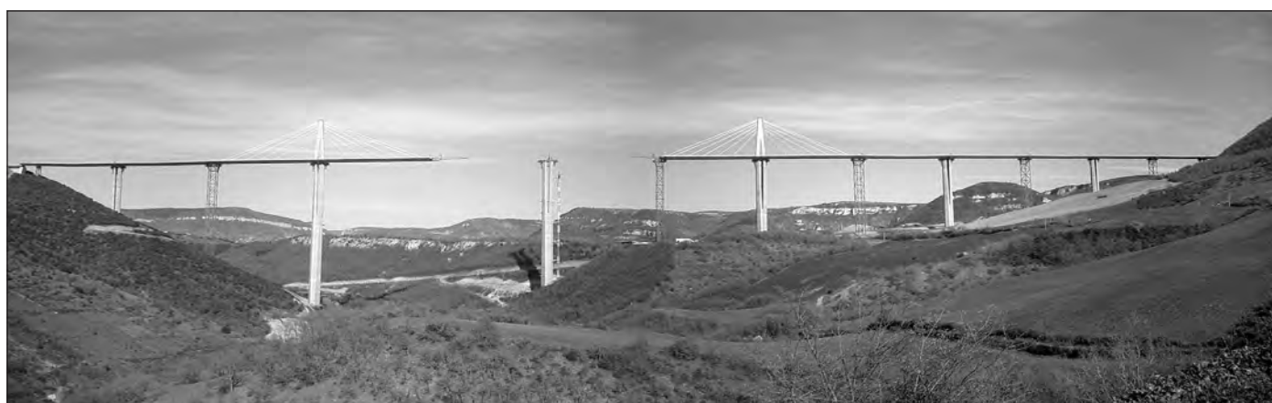
Photo 2 : Lançage du tablier (© Eiffage)
