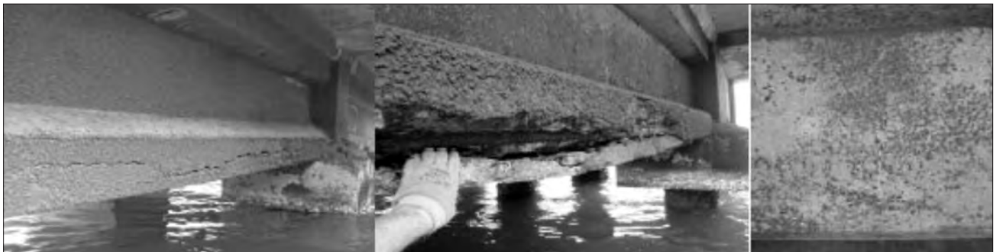
Figure 6. Fractures, aciers corrodés et fissure oblique sur les poutres du quai n°9 de Jarry
