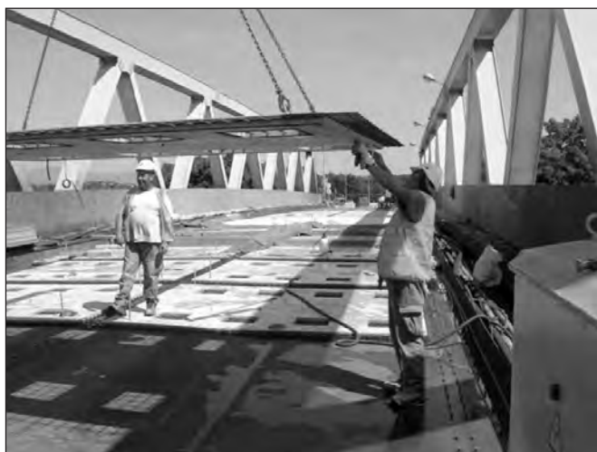
Photo 7 : Pose des dalles préfabriquées
