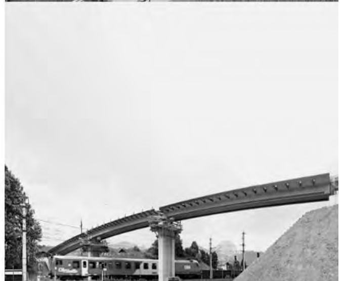
Figure 6 : Phase de construction du tablier en Poutre Préco [8], [6]
