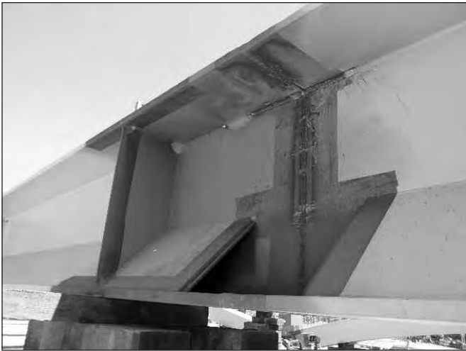
Figure 15 : Détails d'un caisson triangulaire
