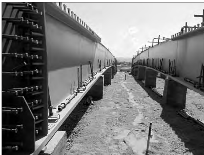
Figure 29 : Charpentes métalliques et encastnements
