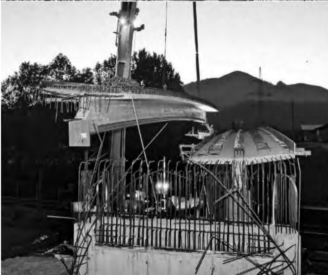
Phase de construction du tablier en Poutre Préco [8], [6]
