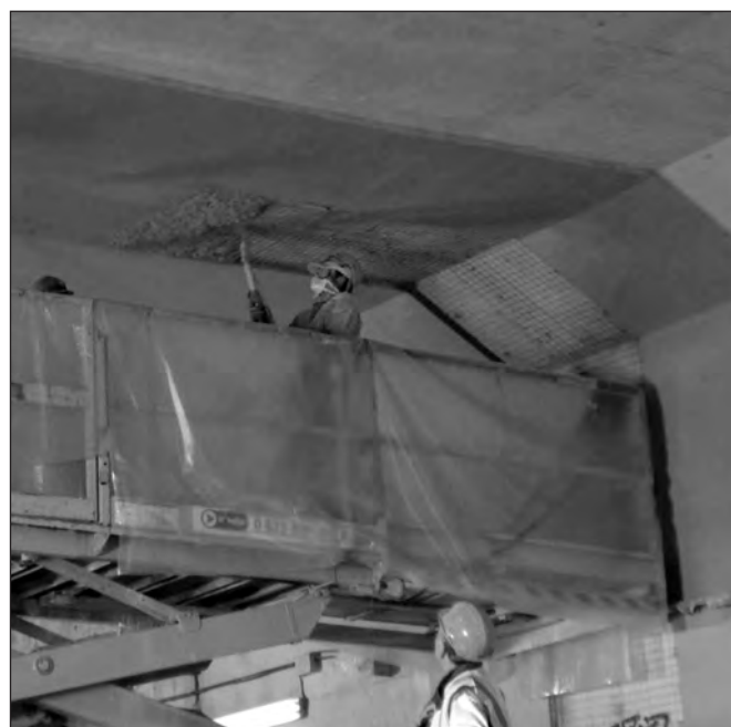
Mise en place de matériaux projetés
