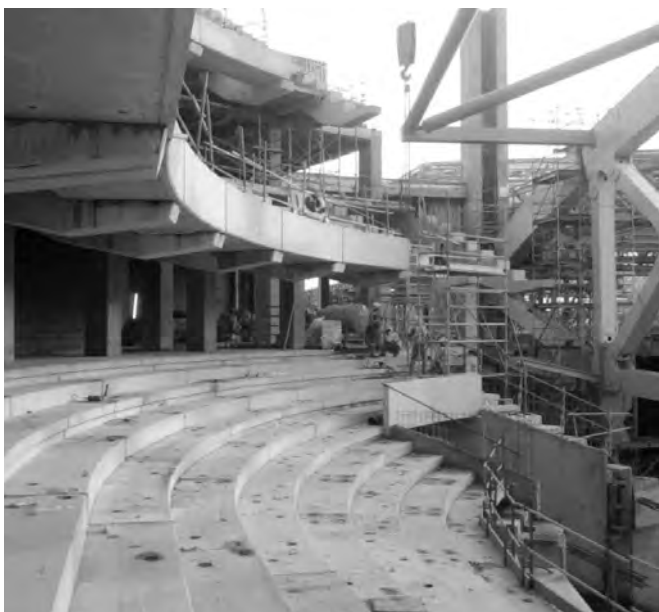
Les éléments de gradins préfabriqués sont solidarisés mécaniquement entre eux et aux crémaillères pour former diaphragme.
