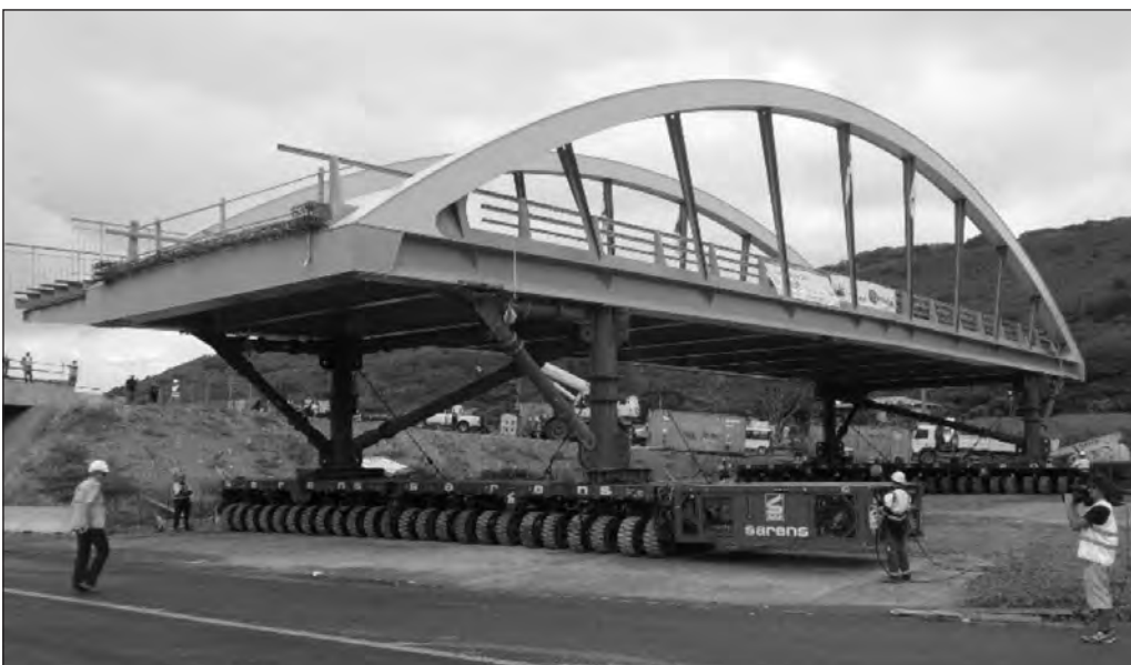
Figure 17 : Vue du montage et aspect du premier mode critique intéressant la suspente
