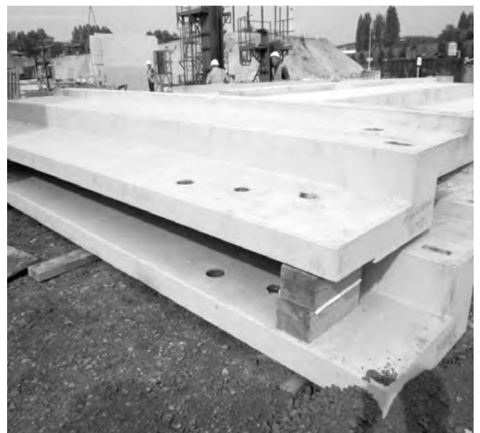
Les éléments de gradins préfabriqués sont solidarisés mécaniquement entre eux et aux crémaillères pour former diaphragme.
