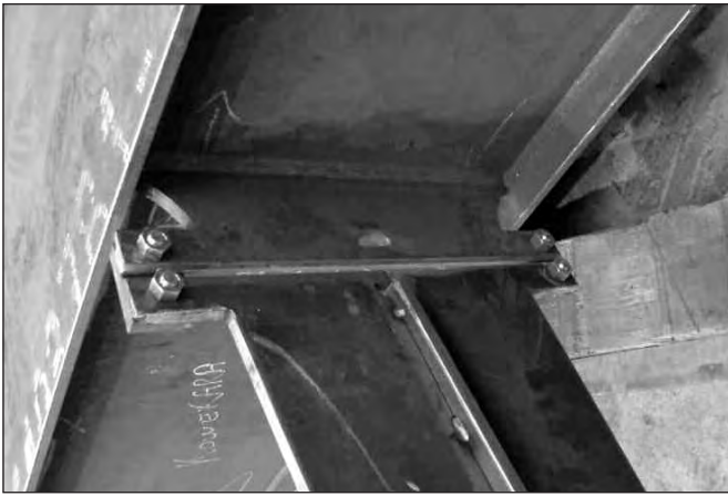
Figure 12 : Attache supérieure d'une suspente
