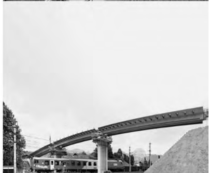
Phase de construction du tablier en Poutre Préco [8], [6]
