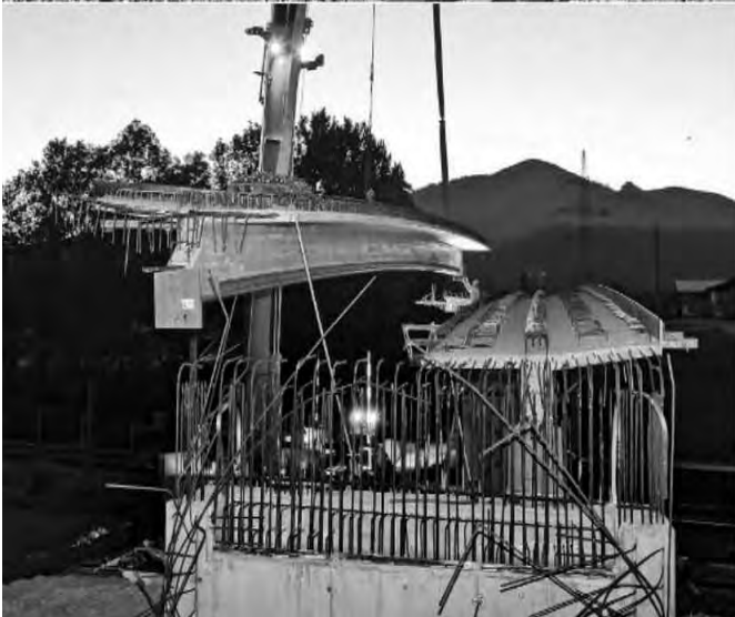
Figure 6 : Phase de construction du tablier en Poutre Préco [8], [6]
