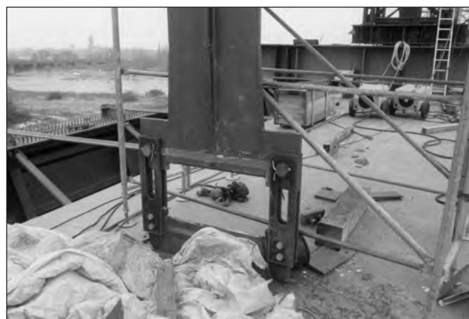
Figure 9 : Pied d'une suspente du pont de Wittenberg
