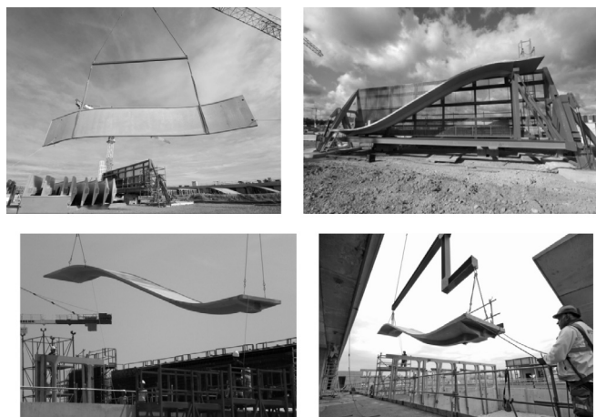
Figure 21 : Phases provisoires des coques courbes sur chantier
