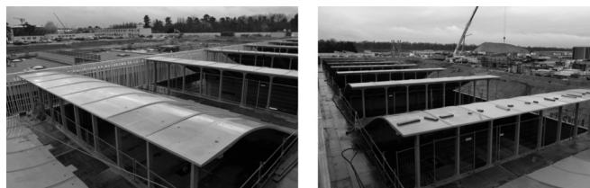
Figure 23 : Couverture des cuves BIOSTYR® en coques BSI®
