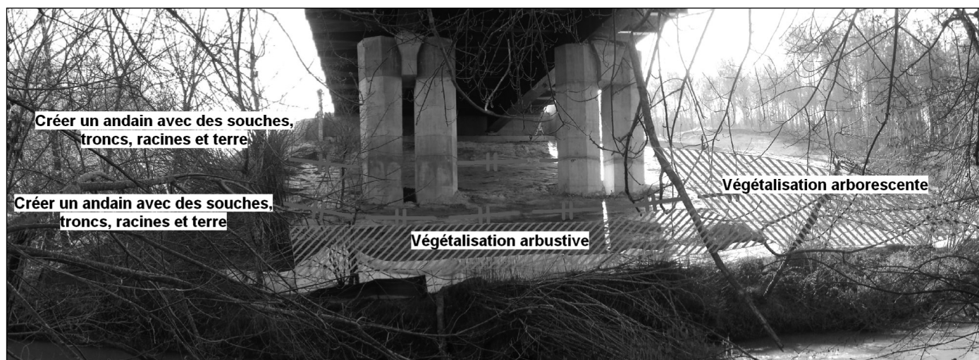
Figure 6 : Illustration des travaux de remise en état définis sous le viaduc de la Douze après expertise faune
