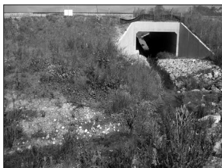
Aménagements externes d'un ouvrage de rétablissement hydraulique de type cadre (banquettes pour le maintien du corridor faune, enrochement au niveau du rescindement).
