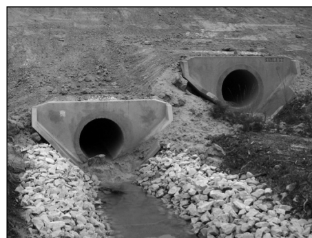
Dans la traversée du massif landais, des buses sèches 8 associées à un OH de type 4 ont été positionnées en moyenne tous les 300 m.
