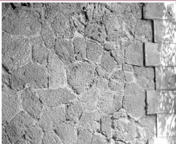
Figure 11. - (a) Pont de Montsalvy, détail de maçonnerie à moellons smillés à assise horizontale. (b) Pont du Leingary, murs en maçonnerie de moellons à joints incertains (opus incertum) et chainage en pierre de taille.
