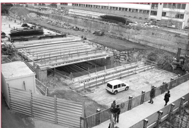
Figure 18. Aspect du site à la fin de la démolition du Pont-Vieux avec une passerelle piétonne provisoire.
