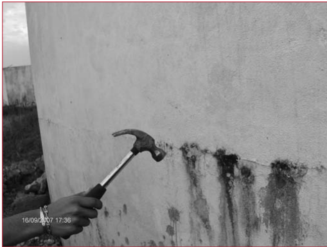
Photo 2. Fissure horizontale au niveau de la bande du fond de la paroi [10].
