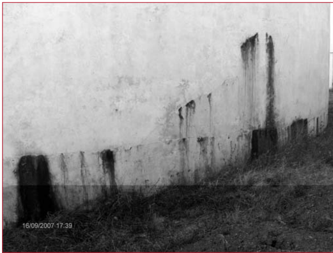
Photo 3. Fissures inclinées à la base de la paroi [10].
