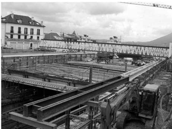
Figure 9. Portique lanceur des poutres en dalle courante.
