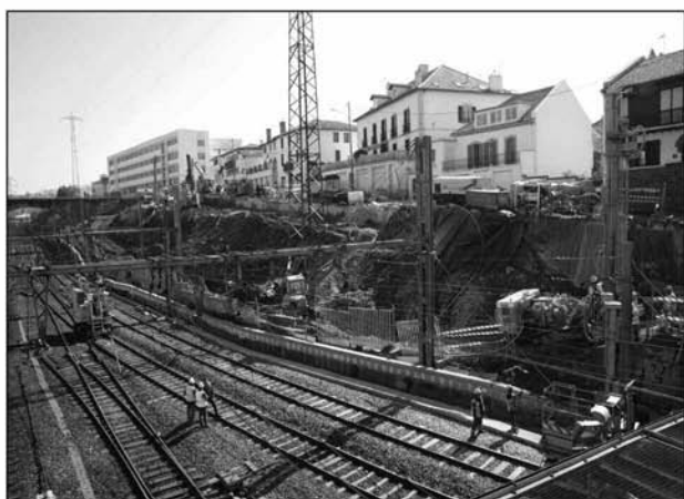
Figure 4. Déplacement du plan de la caténaire et exécution des talus d'accès au fond de la tranchée.
