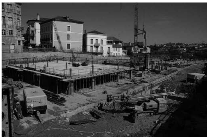
Figure 20. Dalle intermédiaire en cours d'exécution et épreuve de charge du « nouveau Pont-Vieux ».
