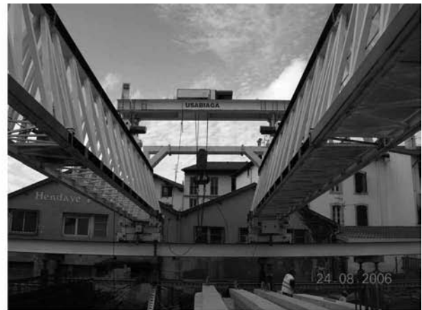
Figure 9. Portique lanceur des poutres en dalle courante.
