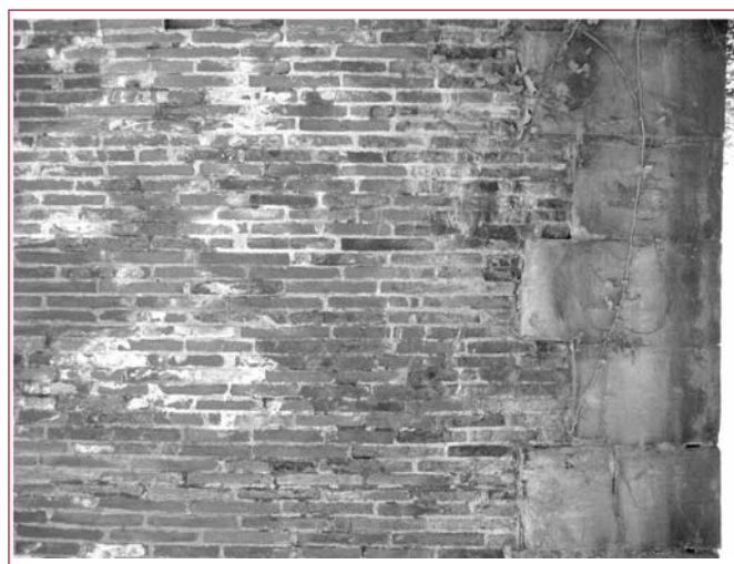
Figure 9. Détail des voûtes en briques avec bandeaux en pierre de taille. Pont de la Millette.
