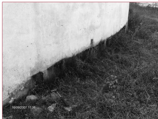
Photo 1. Fissure horizontale à la base de la paroi [10].
