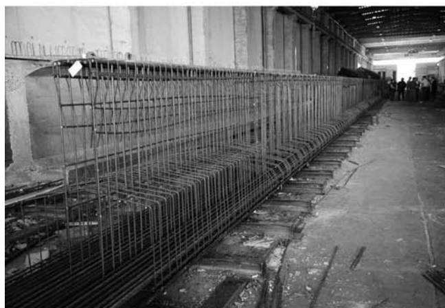
Figure 6. Poutre en cours de fabrication et une fois fabriquée (à remarquer les réservations de passage pour la précontrainte transversale en deuxième phase.
