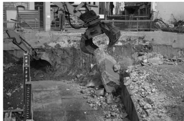
Figure 17. Pont-Vieux en cours de démolition et état d'avancement des travaux lors du démontage du voussoir de clé.
