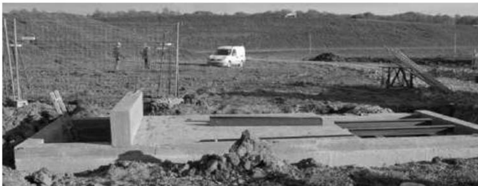
Figure 2. Fosse en béton armé (7 m × 4 m × 2 m).
