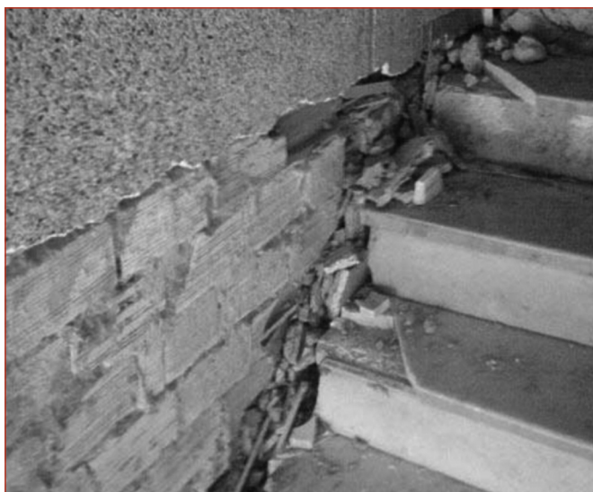
Figure 10: Dislocation de la cage d'escalier et éclatement des revêtements.
