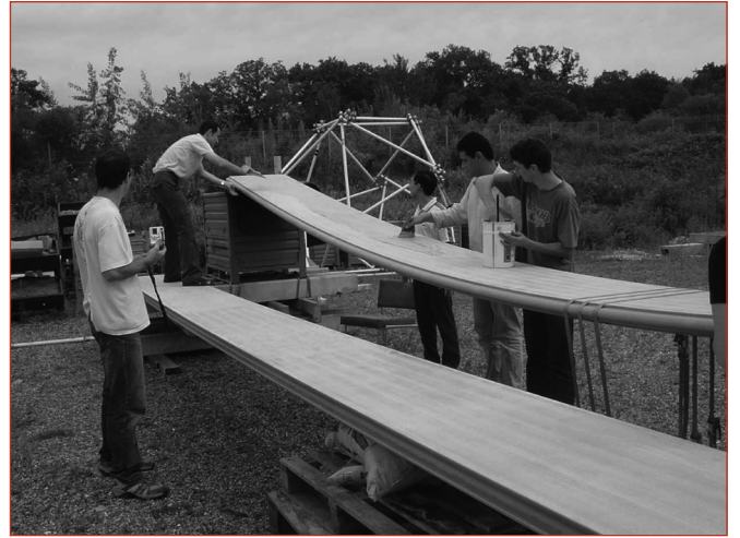
Figure 9 : Préparation du collage.
