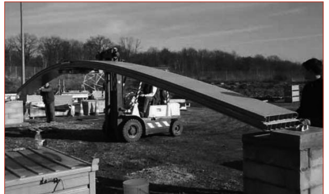
Figure 11 : Positionnement de la poutre dans sa position finale.
