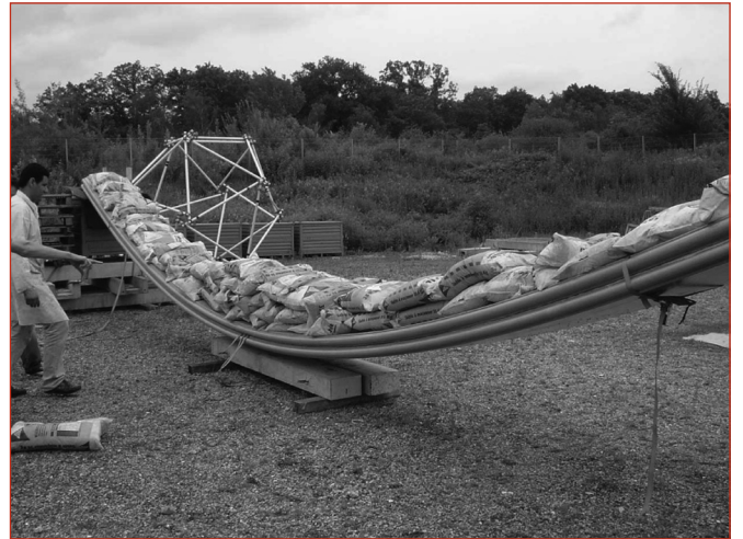
Figure 10 : Collage des poutres.
