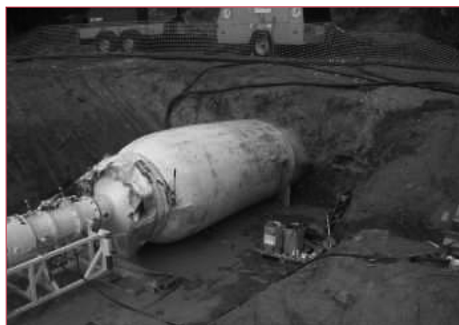
Figure 5: Gonflage de la gaine puis polymérisation en place à la vapeur d'eau à 110°
