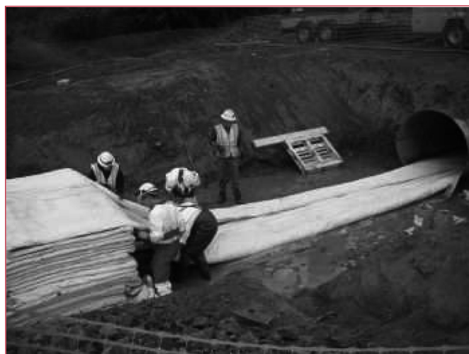
Figure 4: Enfilage de la gaine principale à l'aide d'un câble.
