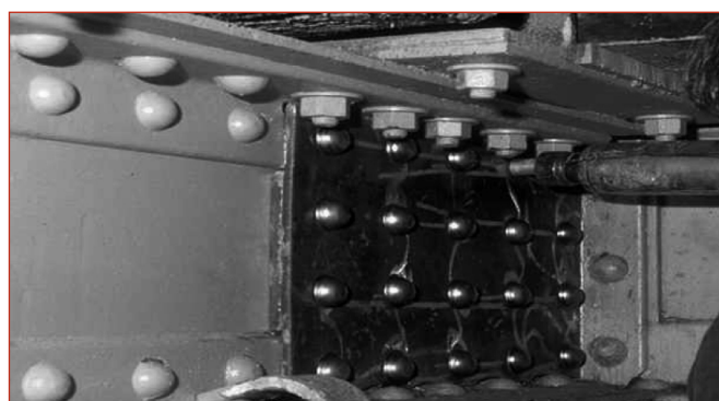
Figure 11: Réalisation d'une triplure.
