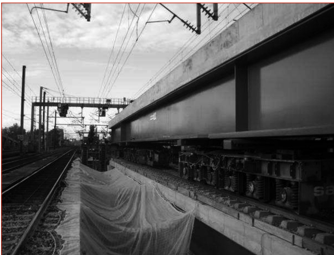
Figure 20: Amenée de la nouvelle travée.
