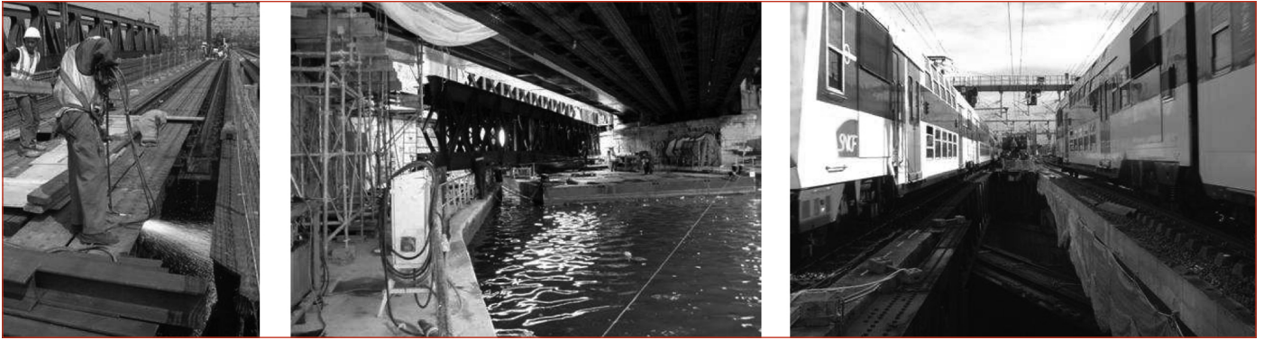
Figure 19: Découpe et évacuation du tablier ancien par dessous au milieu des circulations ferroviaires.
