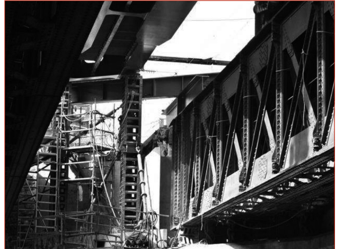
Figure 21: Dévérinage de la nouvelle travée sur tours d'étaisements.
