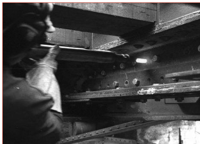
Figure 10: Remplacement de rivets.
