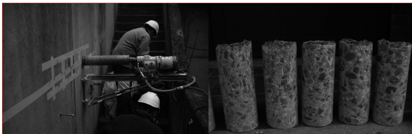
Figure 1 : Illustration du carottage sur voile et des échantillons prélevés.
