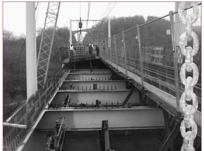
Figure 22: Dépose du demi-tablier de l'ouvrage ancien.
