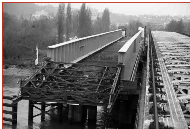
Figure 17: Charpente du tablier neuf en cours de lançage.
