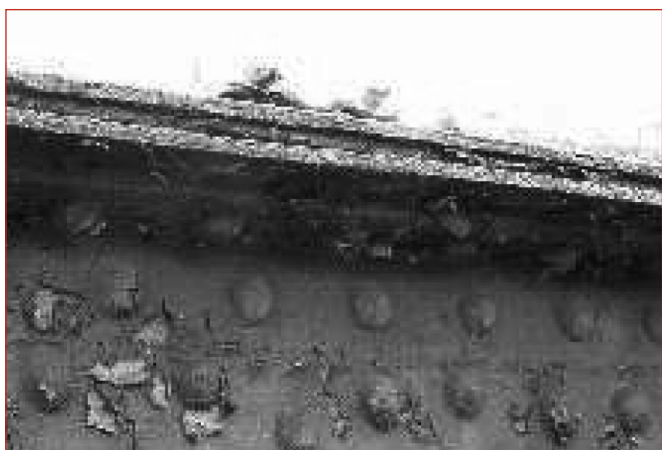
Figure 9: Exemple de corrosion de semelle.
