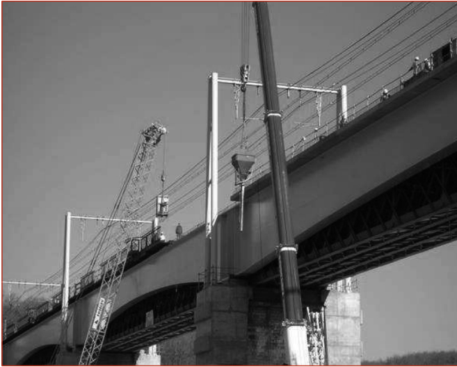
Figure 23: Bétonnage du demi-hourdis du nouveau tablier.
