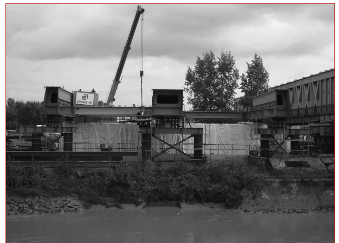
Figure 13: Charpente métallique du nouveau tablier.
