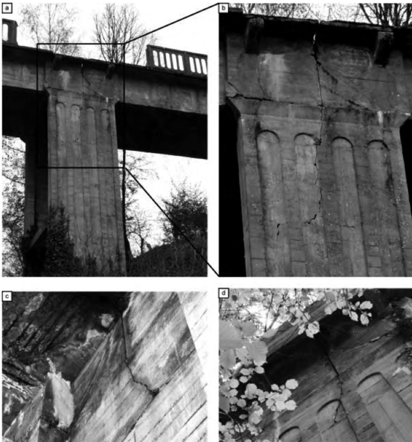
Figure 5. Observations sur les piles. a : pile faisant face au moulin de Lascaux (façade nord-ouest du pont) et détail en b. On note la présence d'une fissure majeure plurimétrique. Avril 2017. c : cette fissure se retrouve sur la pile située à l'autre face. Mai 2018. d : la pile située sur la rive Lascaux, façade nord-ouest, montre également une fissuration importante. Mai 2018.
