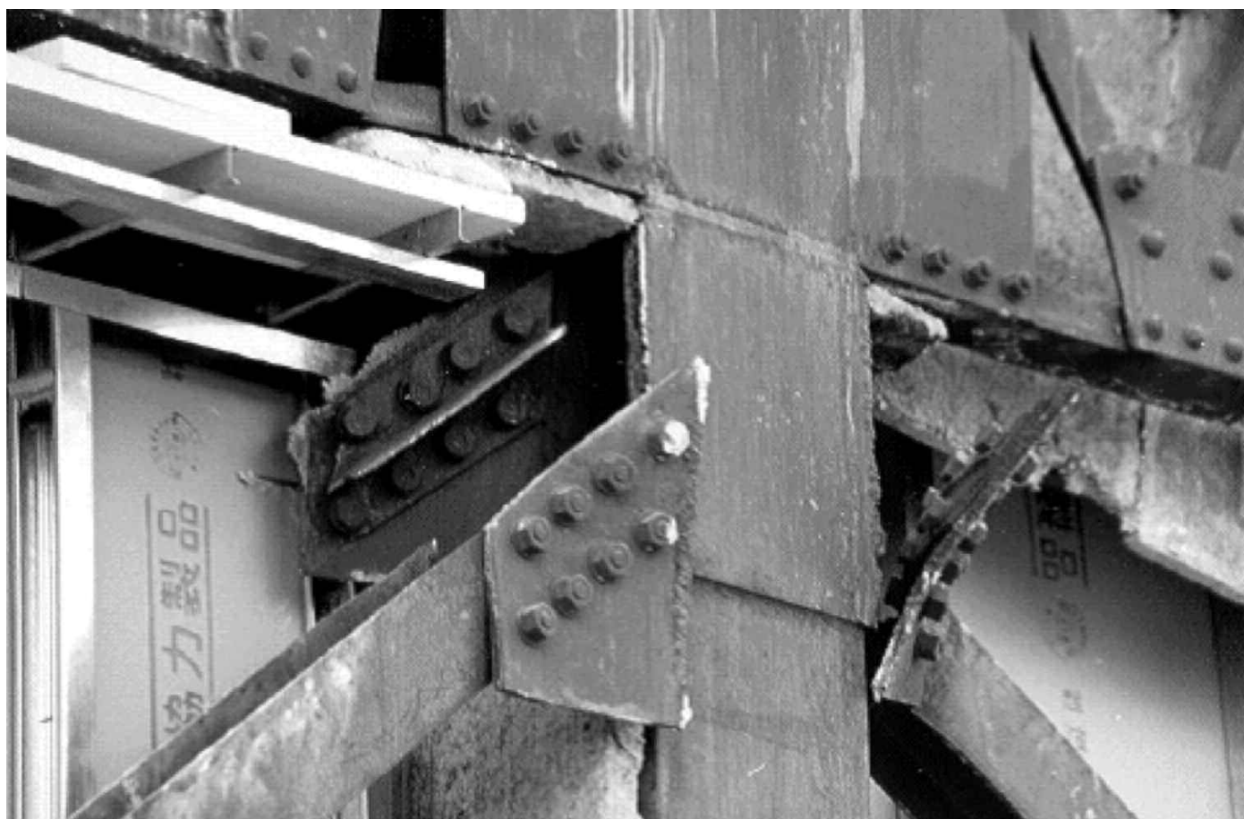
Rupture des éléments non ductile (contreventement en X), séisme de Kobe.
