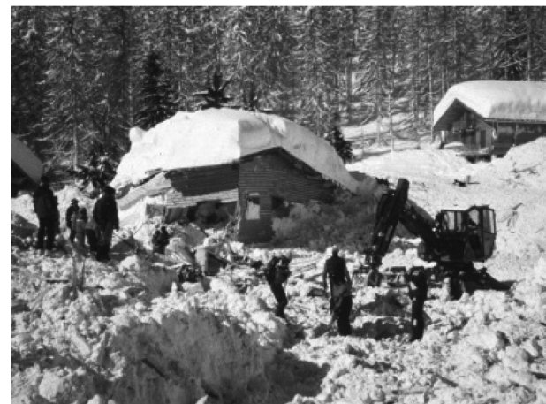
Figure 1. Chalet détruit à Montroc, en Haute-Savoie, en février 1999 (Source : C. Ancy)
