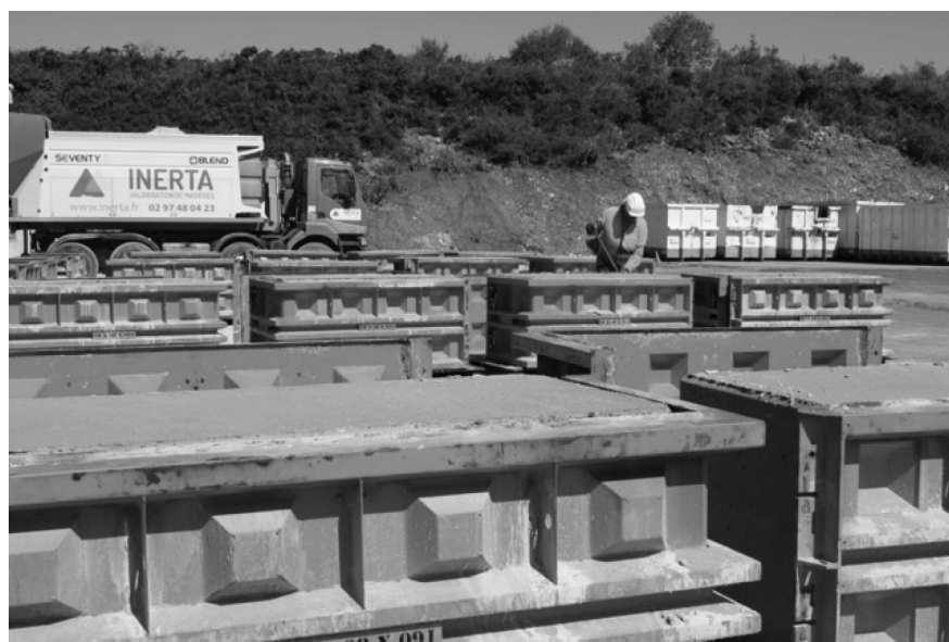
Coulage des blocs sur site - INERTA
