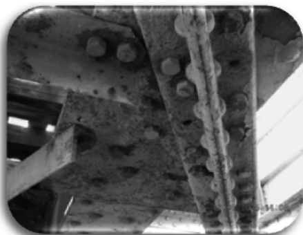
Figure 9 : Corrosion sévère d'une attache.
