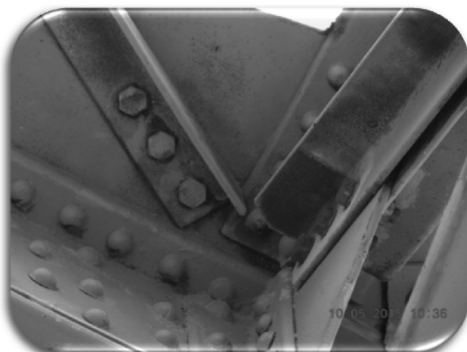
Figure 13 : Remplacement des rivets par des boulons.
