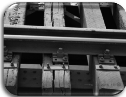
Figure 11 : Traverse en bois fracturé et des attaches perdues.
