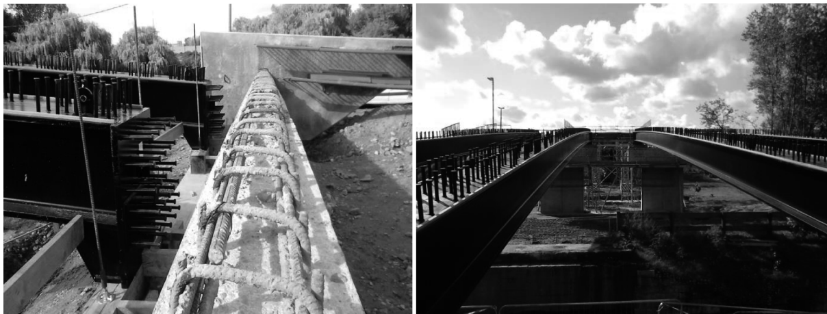
Figure 7 : Pose de la charpente métallique en phase provisoire.
