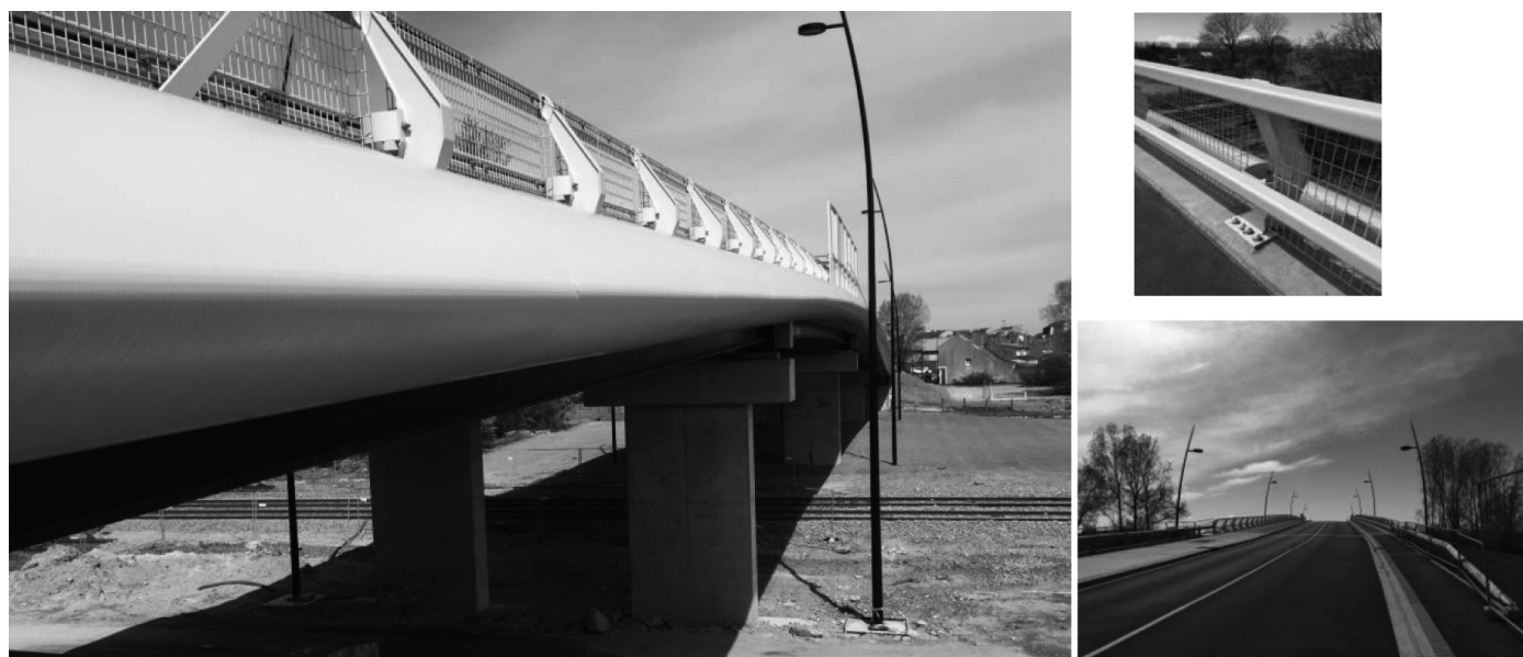
Figure 3 : Détails de la corniche, du garde-corps et des candélabres.
