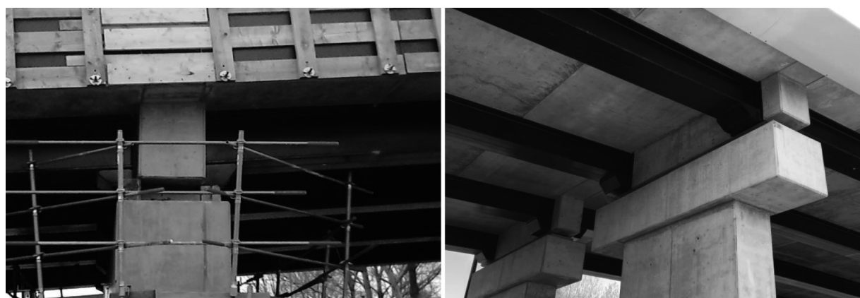
Figure 9 : Détails de la liaison de continuité par chevêtre en b.a.
