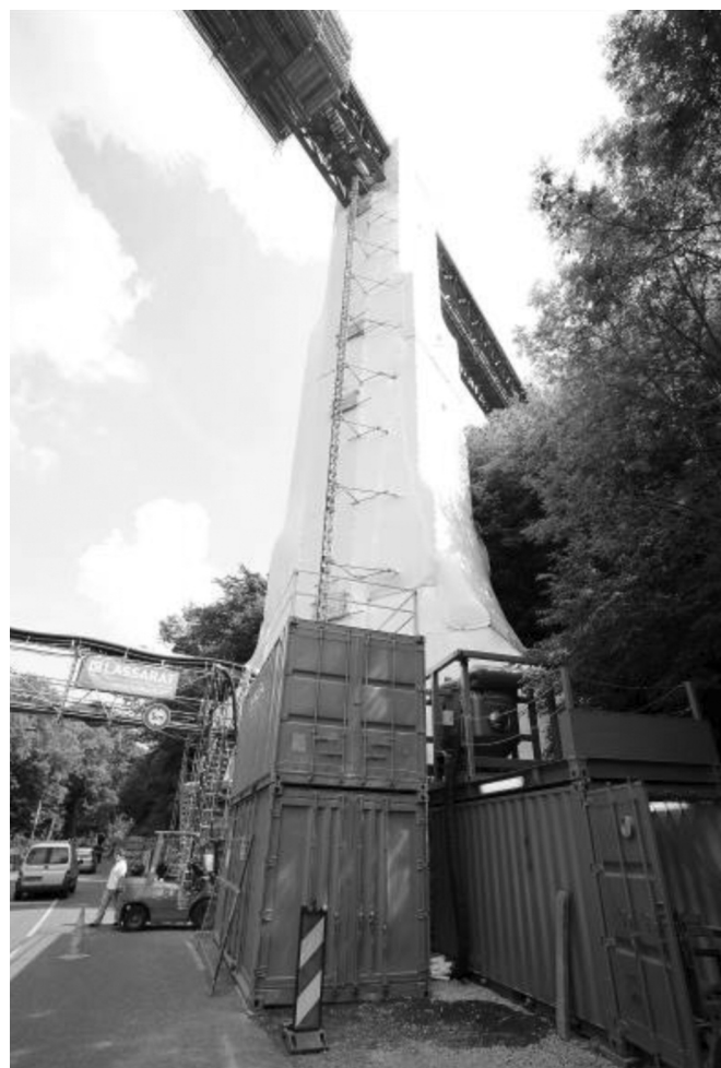
Figure 14 : Système de sablage.
