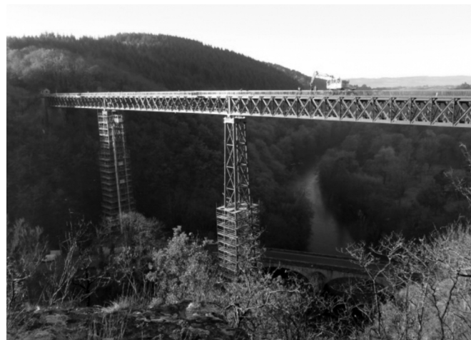
Figure 16 : Dépose des derniers échafaudages et repose de la voie.
