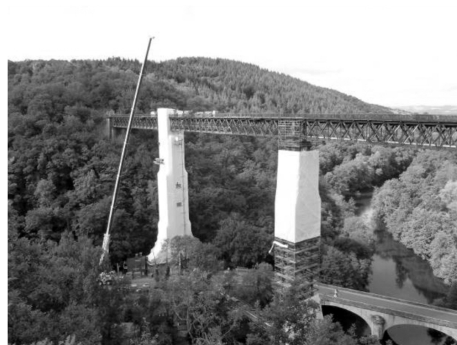
Figure 12 : Mise en œuvre des échafaudages roulants par grue de 200 t.
