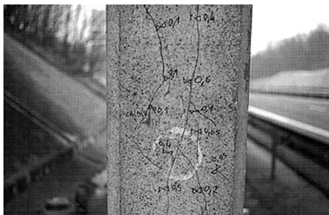
Figure 2 : Faïençage d'une pile de pont.
