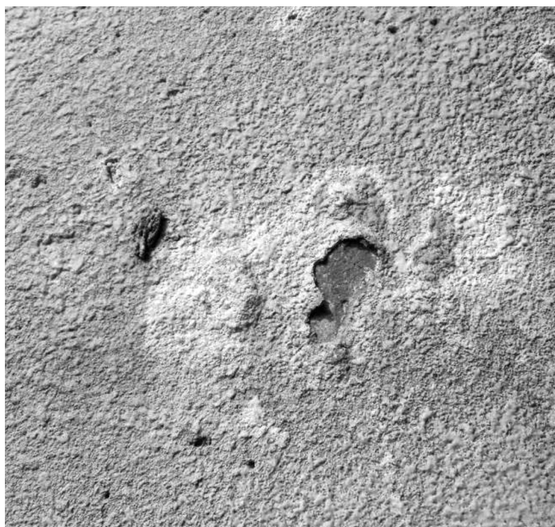
Figure 22 : Cloquage du revêtement du PI 361.
