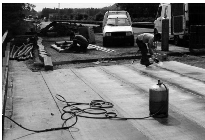
Figure 9 : Réfection de l'étanchéité du tablier du PI 328.
