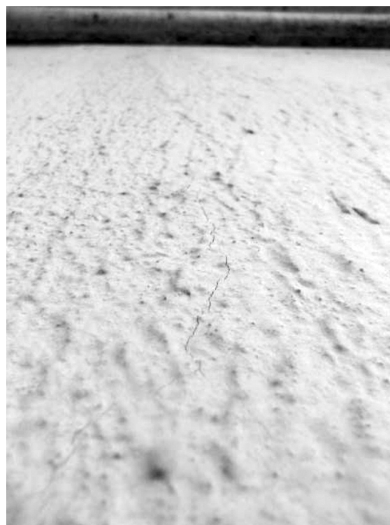
Figure 23 : Fissuration du revêtement du PS 357.
