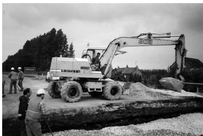
Figure 13 : Retrait du remblai à la pelle mécanique.
