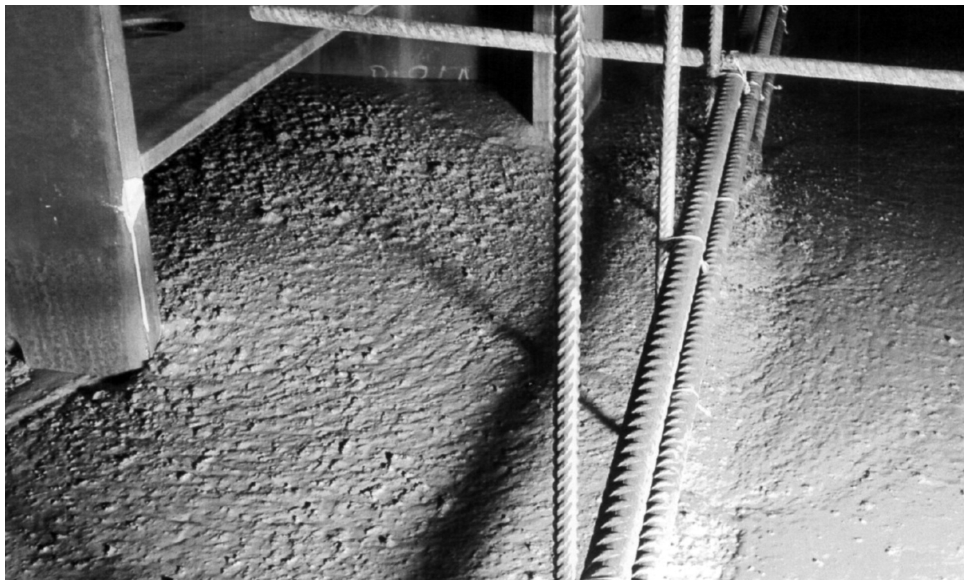
Photo n° 15 : SCC de blocage des blindages.
