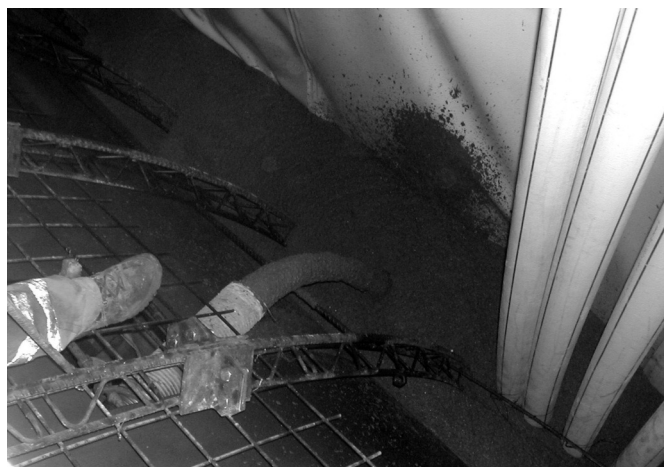
Photo n° 8 : Mise en place du béton.
