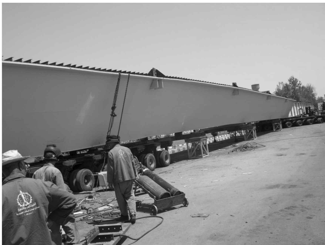
Figure 6 : Charpente métallique dans sa totalité en cours de chargement en atelier.
