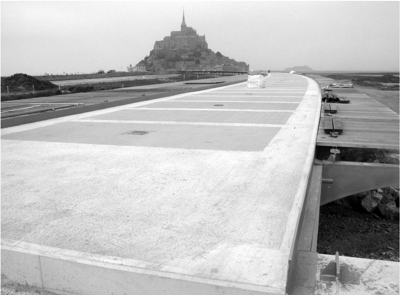
Fig. 15. Culée sud bétonnée en même temps que les clavetages autour des dalles préfabriquées (été 2013). Abutment South, poured with concrete, at the same time with the keying-in around the concrete slabs of the bridge deck (Summer 2013).
