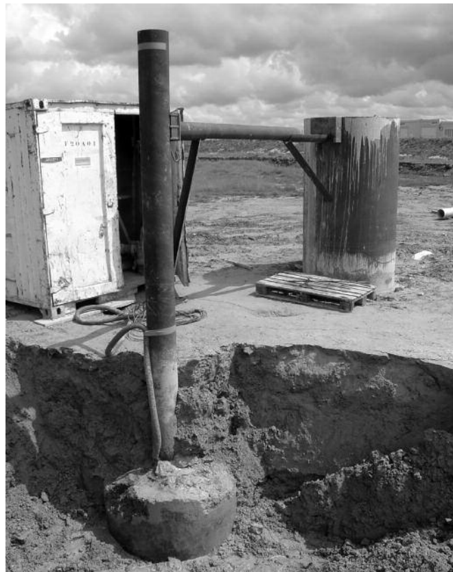
Fig. 10. Excavation après l'essai pour constater visuellement l'état du pieu (juin 2012).
