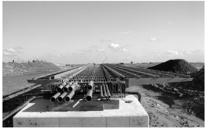
Fig. 12. Culée nord avant bétonnage de la partie supérieure, largeur 4m (printemps 2013). Abutment North before concreting of the higher part, width 4m (Spring 2013).
