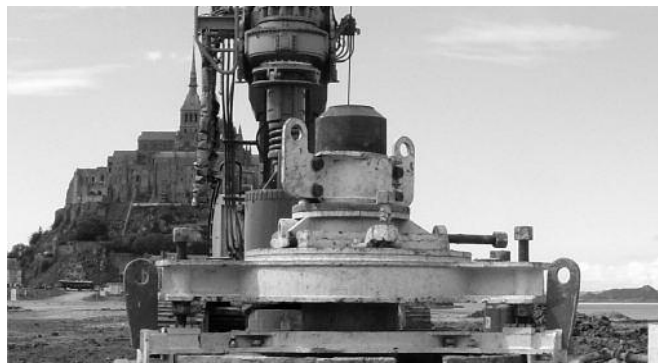
Fig. 6. Dispositif de centrage au niveau du terrain naturel, fixé sur le tube (juin 2012). Centring device on the ground level, fixed on the tube (June 2012)
