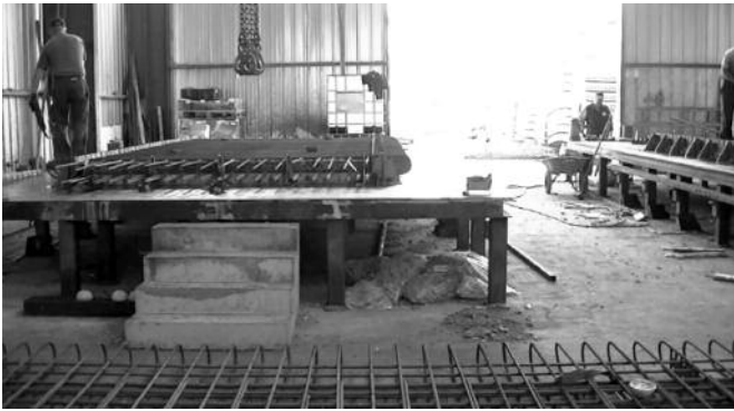
Fig. 16. Usine de préfabrication (été 2012). Prefabricating factory (Summer 2012).
