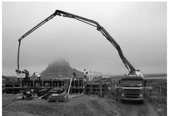
Fig. 14. Bétonnage de la culée sud (été 2013). Concreting of the Abutment South (Summer 2013)
