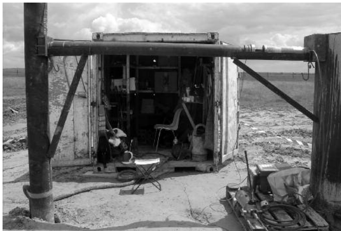
Fig. 9. Dispositif de poussée avec vérin pour le pieu d'essai (situé à gauche) (juin 2012).
