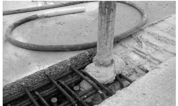
Fig. 19. Clavetage entre deux dalles préfabriquées (été 2013). Keying-in between 2 prefabricated slabs (Summer 2013).
