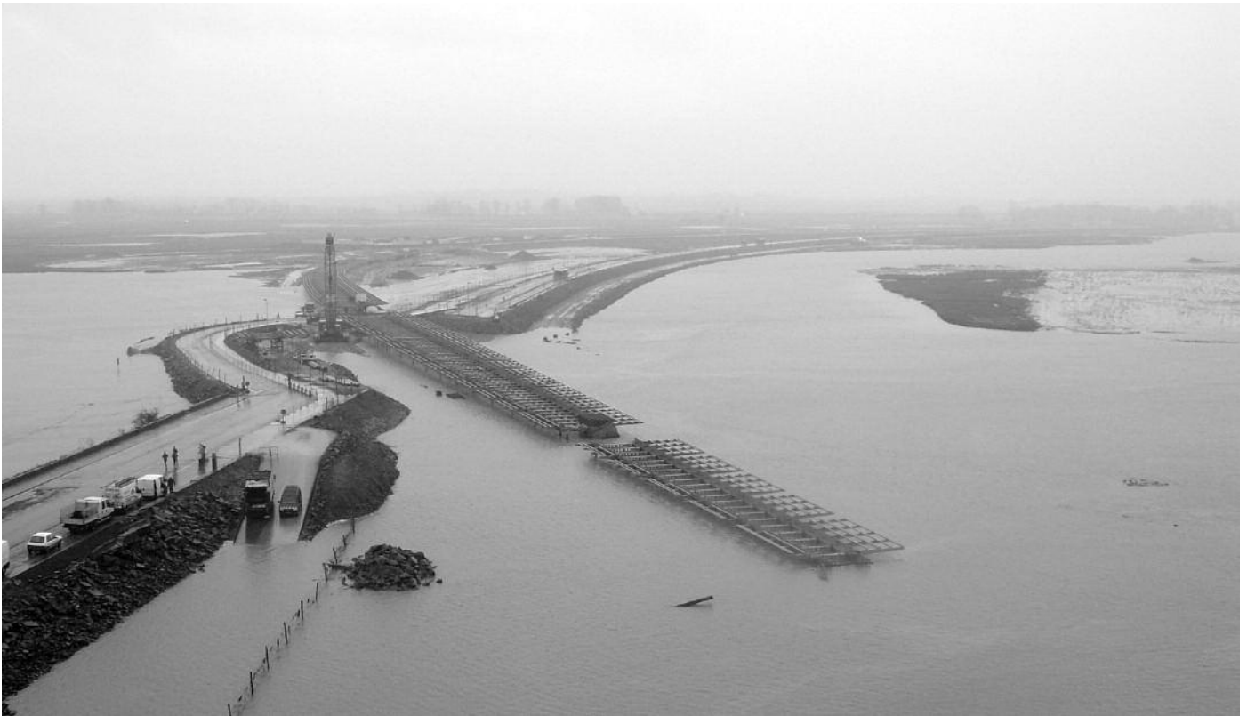
Fig. 3. Pont-passerelle à marée haute (en cours de construction, février 2013). Jetty at high tide (under construction, February 2013).
