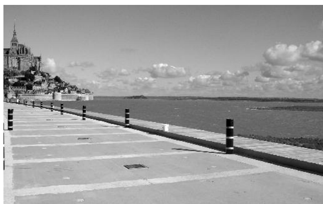
Fig. 2. Le pont-passerelle du Mont-Saint-Michel en construction (septembre 2013) Fig. 2. The jetty of Mont Saint Michel under construction (September 2013)
