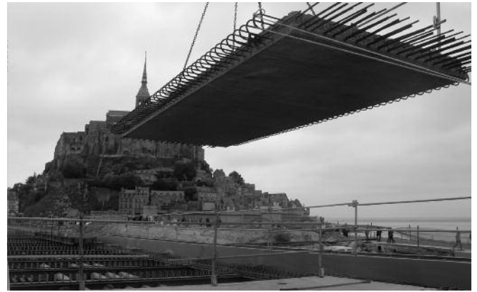
Fig. 17. Mise en place d'une dalle sur un des tronçons du pont-passerelle (été 2013). Setting up of a slab on one of the last parts of the bridge (Summer 2013).
