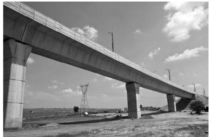
Photo 4 : Viaduc 03 avec voussoirs préfabriqués / Precast segments viaduct 03.
