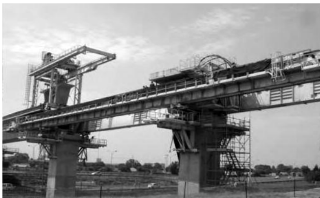
Photo 11 : Lanceur type T2/ Launcher T2.
