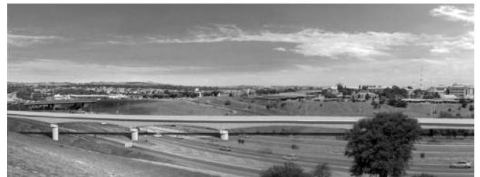
Photo 3 : Viaduc 05d construit par encorbellement avec voussoirs coulés en place / Cast in situ concrete cantilever viaduct 05d.
