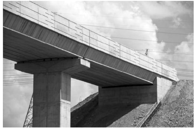
Photo 2 : Pont à poutres précontraintes / Prestressed beams bridges.
