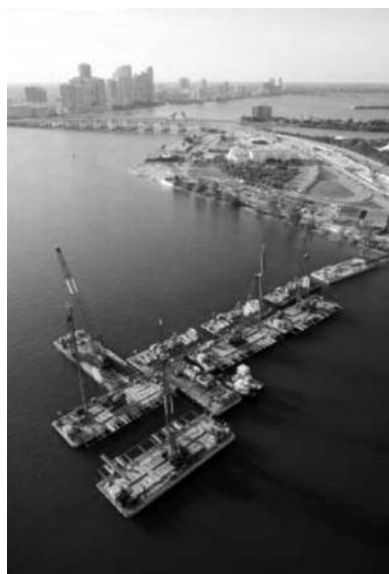
Fig 9. Traitement des terrains par barges / Tunnel Ground Treatment on pontoon
