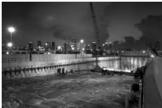
Fig 5. Puits de lancement de Watson
