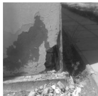
Figure 8 : La corrosion avancée des armatures dans les zones inférieures des poteaux
