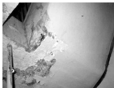
Figure 10 : Corrosion des armatures de la paillasse
