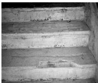
Figure 9 : Dégradation des marches
