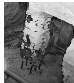
Figure 8 : La corrosion avancée des armatures dans les zones inférieures des poteaux
