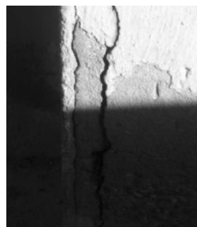
Figure 7 : Des fissures longitudinales
