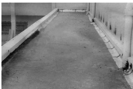
Figure 1 : Etanchéité insuffisante
