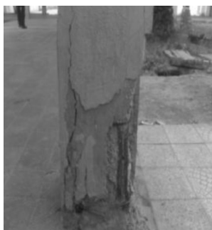
Figure 6 : Des épaufures à la base des poteaux
