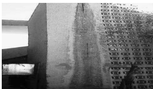
Figure 4 : Altération des murs extérieurs à cause de la défaillance des canalisations
