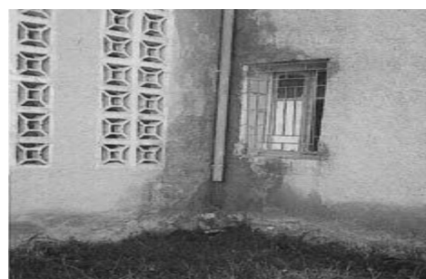
Figure 5 : La remontée capillaire des eaux autour des constructions
