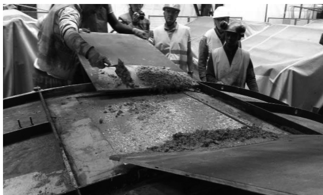
Figure 8 : Coulage des voussoirs instrumentés.
