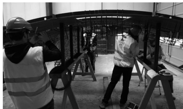
Figures 6 et 7 : Implantation des chaînes de mesure dans les « planches fakir ».
