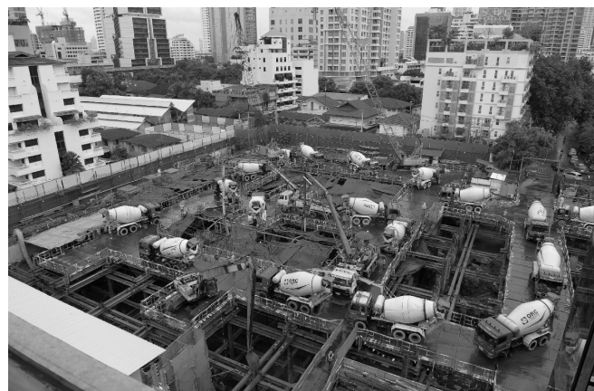
Figure 6 : Concrete trucks on the mat foundation casting date/ camions-toupie pour le radier (Source Bouygues-Thai)
