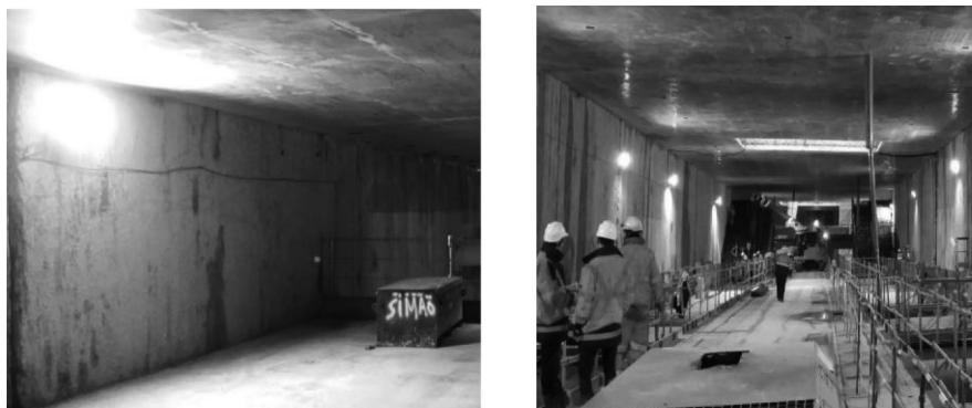
Figure 5. Paroi moulée de la station de métro
