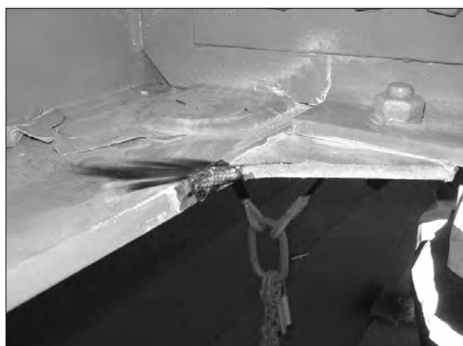
Figure 12 : Détermination par Code_Aster des zones à risques et traitement T.I.G.
