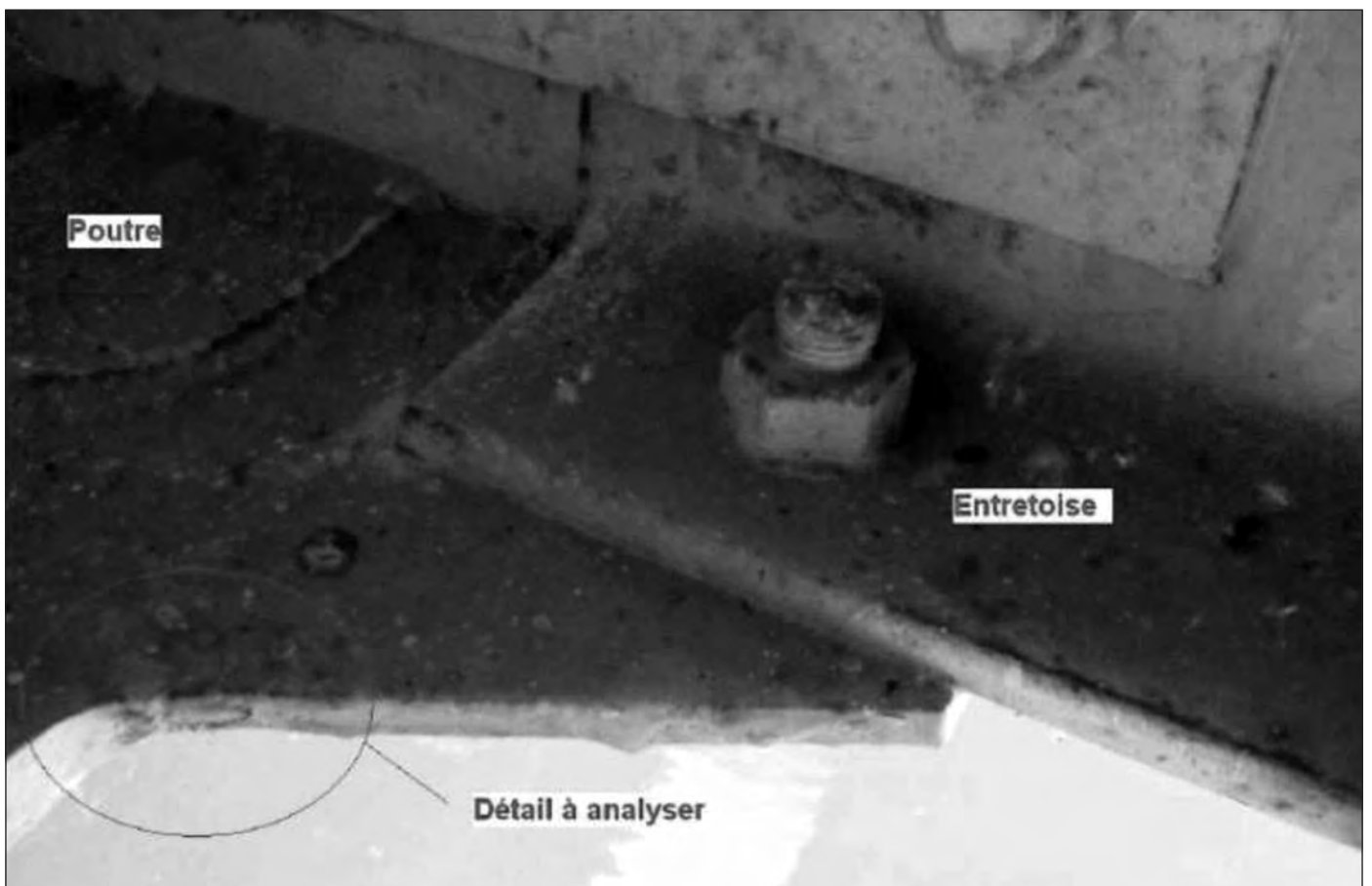
Figure 2 : Goussets arrondis initiaux anti-fatigue (1971 - 1972)
