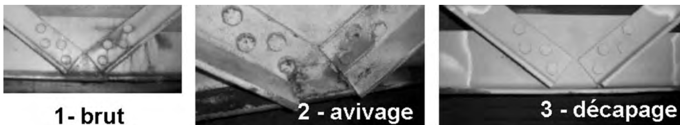
Figure 13 : Nœud d'entretoise : état initial – après avivage – après décapage
