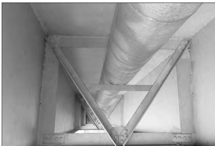
Poutres intermédiaires et dalle mixte
