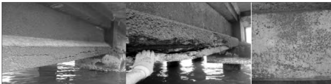
Figure 6. Fractures, aciers corrodés et fissure oblique sur les poutres du quai n°9 de Jarry
