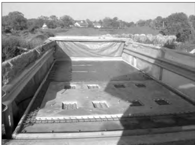
Photo 4 : Tablier VMD - Dalle préfabriquée
