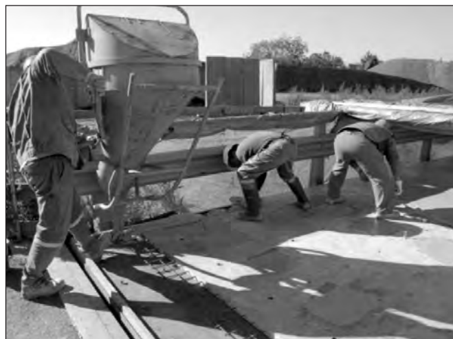
Photo 5 : Tablier VMD - Bétonnage des zones de clavage
