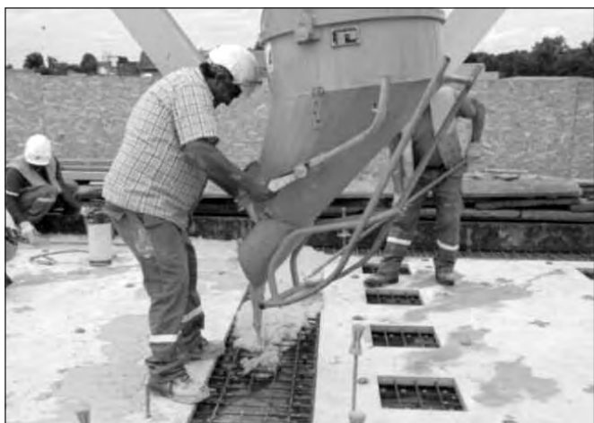
Photo 8 : Pose des dalles préfabriquées
