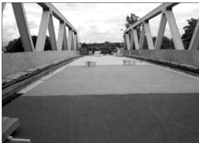
Photo 9 : Mise en œuvre de la couche de roulement
