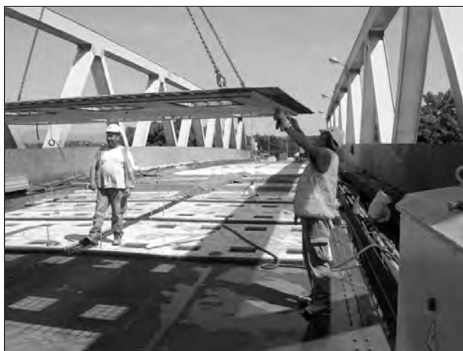
Photo 7 : Pose des dalles préfabriquées
