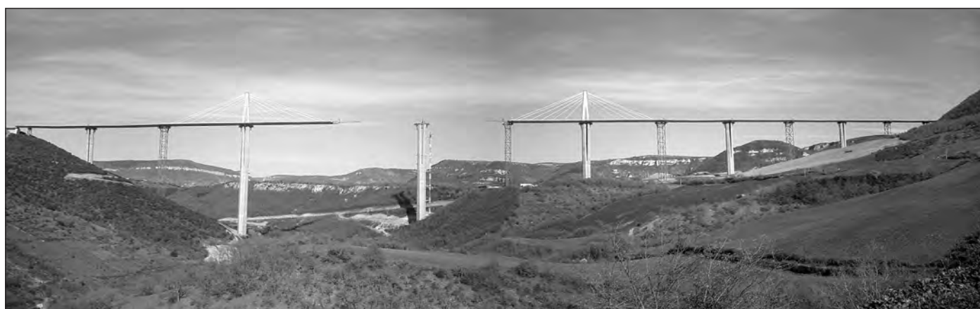
Photo 2 : Lançage du tablier (© Eiffage)
