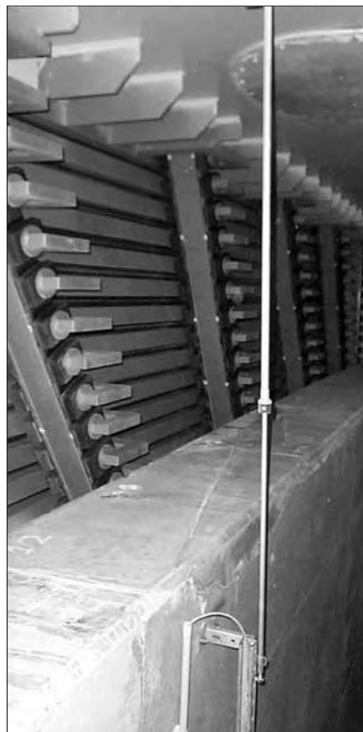
Photo 5 : Joint de chaussée et capteur (© SITES)
