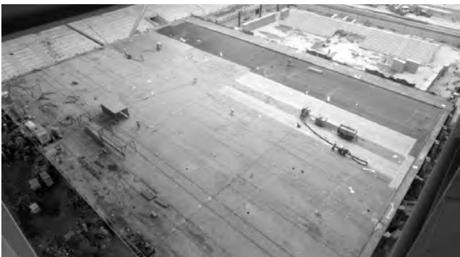
Traitement par grenaillage et feuille préfabriquée de l'étanchéité du plateau
