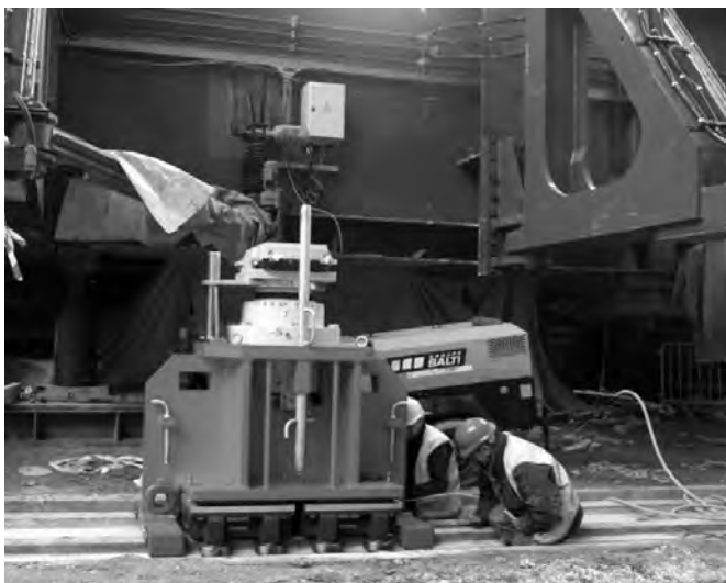
Chariot de translation : de bas en haut rouleurs SED, châssis NFM, vérin de compensation Douce Hydro, appui Maurer
