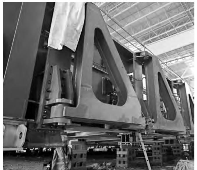
Bras en cours de montage.
