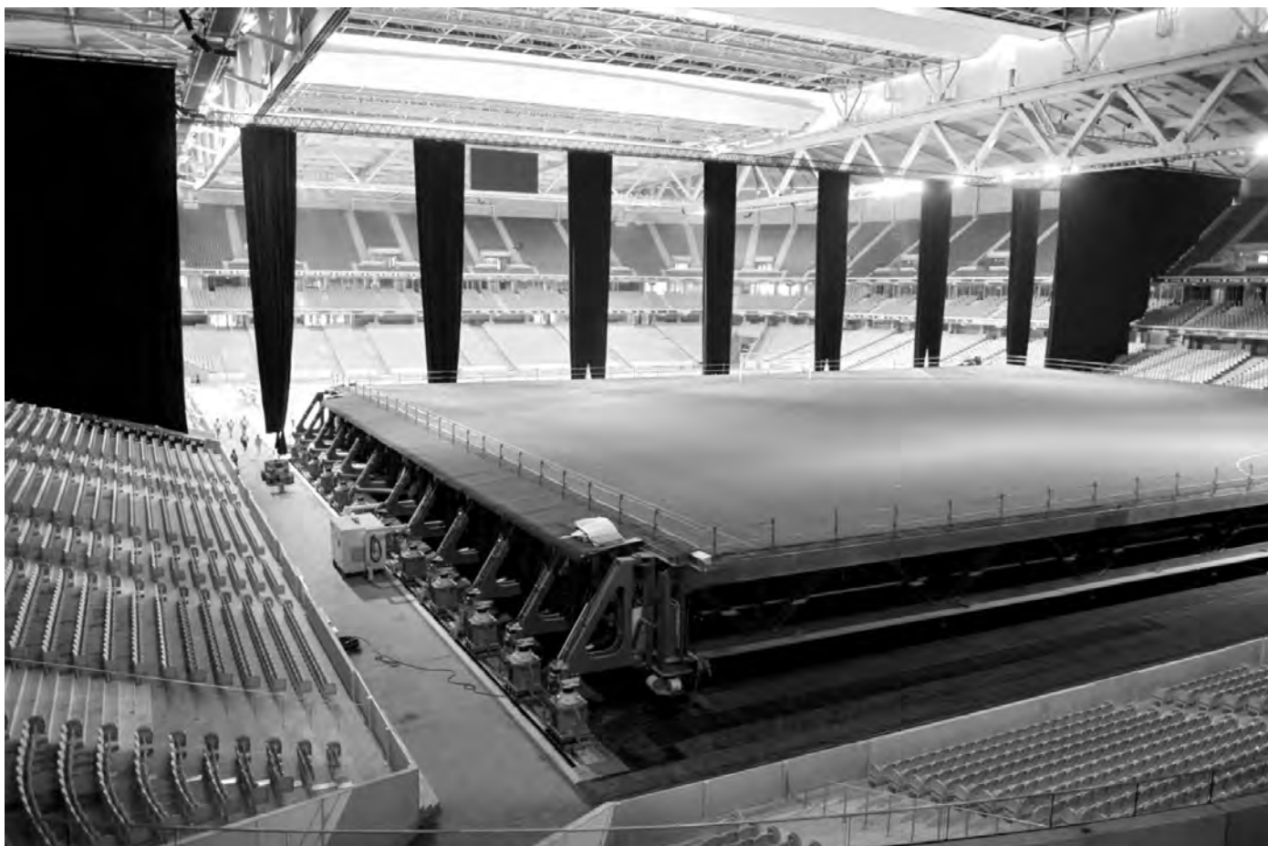
11 Septembre 2012 : le plateau mobile ouvert en position de stockage dans les coulisses de la boîte à spectacles.
