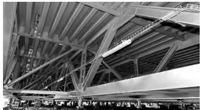
Vue en sous-face du plateau mobile : poutre treillis, dalle orthotrope, appareil d'appui en fond de fosse.
