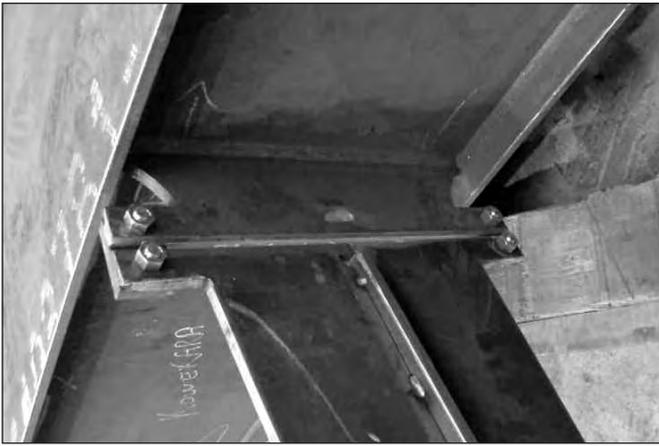
Figure 12 : Attache supérieure d'une suspente
