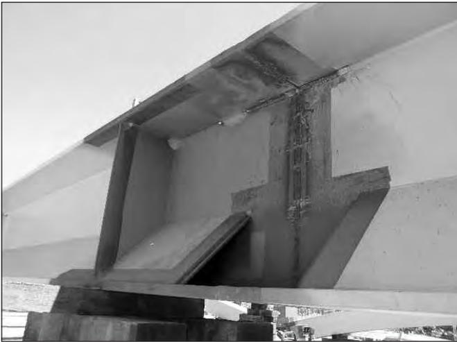
Figure 15 : Détails d'un caisson triangulaire
