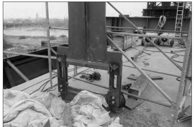
Figure 9 : Pied d'une suspente du pont de Wittenberg
