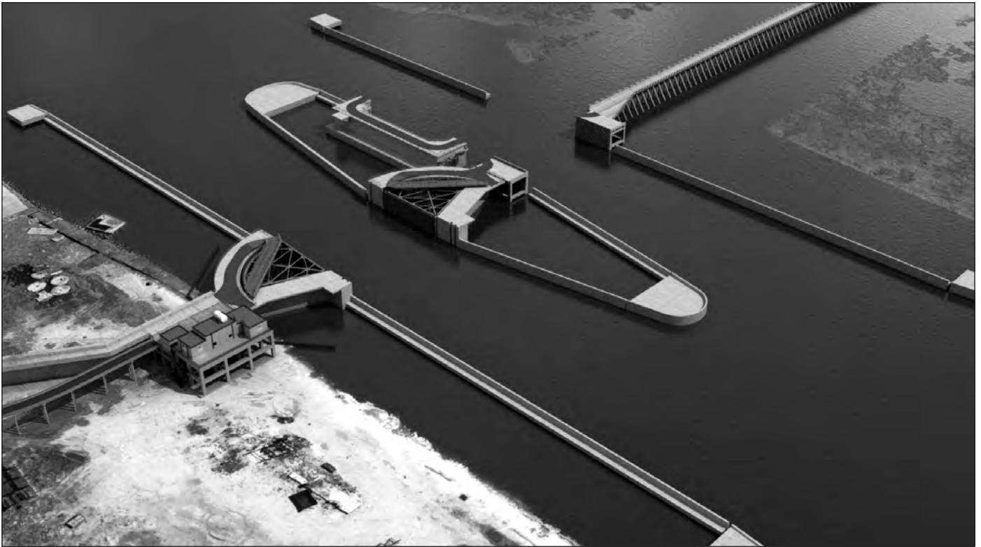
Barrière anti-tempête du canal de navigation du port intérieur
