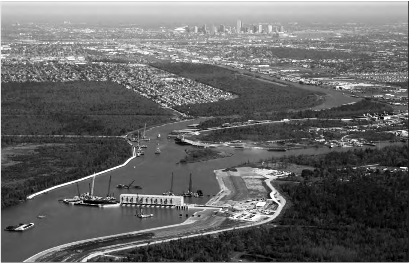
Le complexe de fermeture Ouest et la station de pompage
