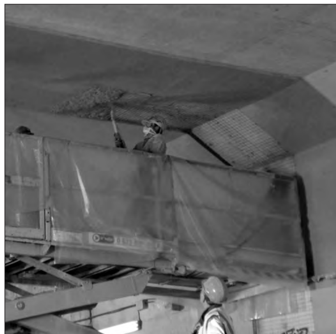
Mise en place de matériaux projetés
