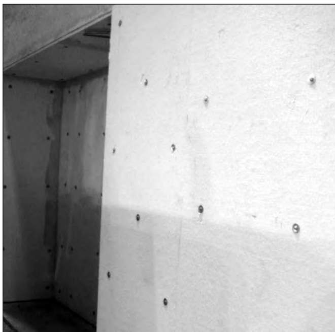
Mise en place de plaques
