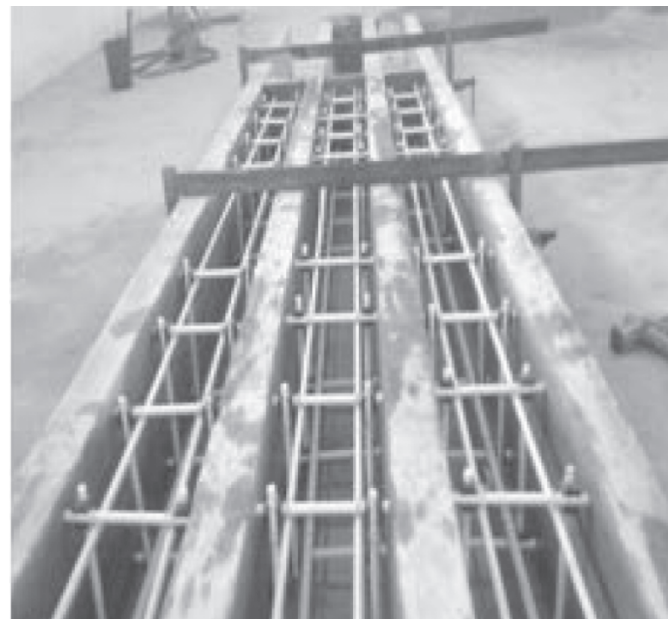
Figure 4 : Coffrage et mise en place des armatures en acier et en PRFV
