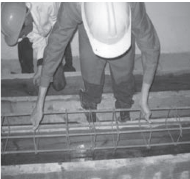
Figure 4 : Coffrage et mise en place des armatures en acier et en PRFV
