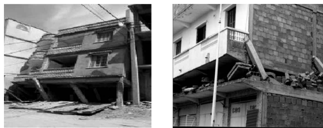
Figure 1 : Ruine par mécanisme plastique d'étage (Boumerdès, Algérie, 2003)
