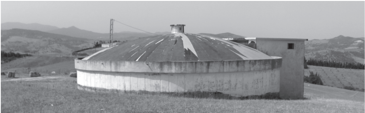
Figure 1 : Réservoir circulaire semi enterré en béton armé (Photo Hammoum)
