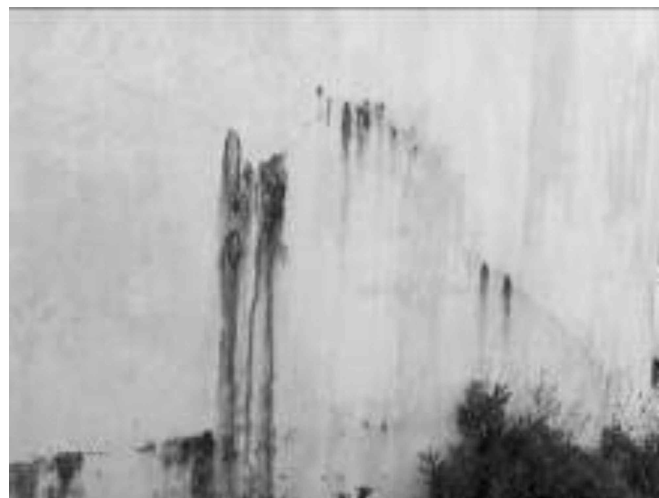
Figure 4 : Suintement et fissures sur la paroi
