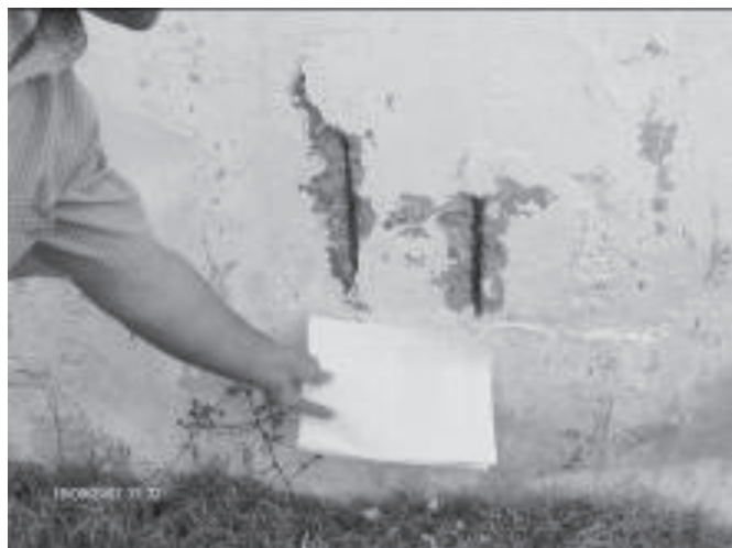
Figure 3 : Corrosion des aciers
