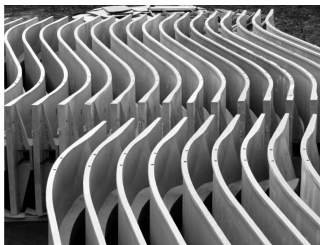
Figure 18 : Stockage avant mise en tension
