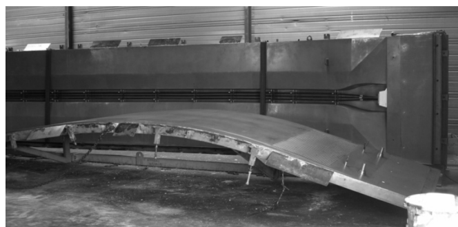
Figure 16 : Coffrage métallique des coques courbes
