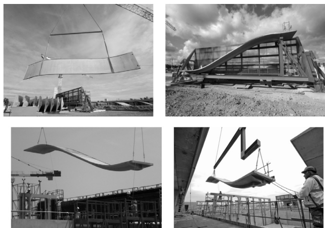
Figure 21 : Phases provisoires des coques courbes sur chantier
