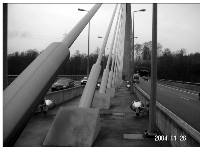
Figure 4 : Pont de Hesperange – nappe de haubans en enfilade
