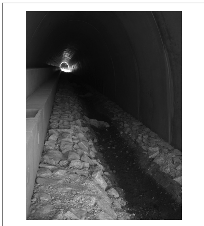
Aménagements internes (banquette avec piège à trace, enrochement, lit en forme de V, barette)
