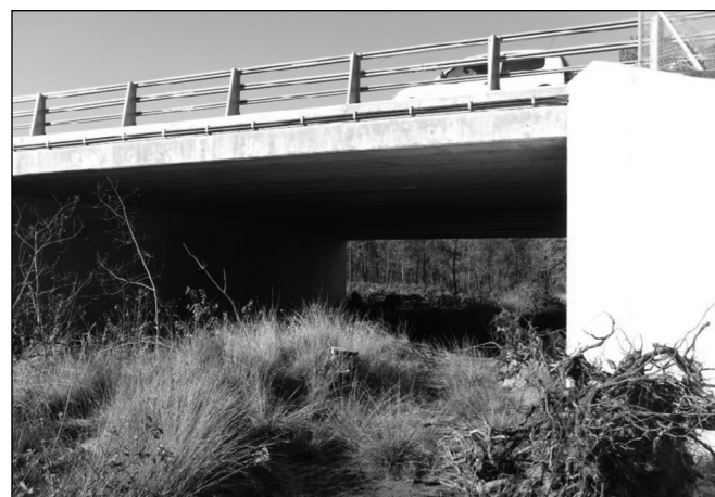
Ouvrage portique enjambant le lit mineur du Lep avec mise en place de souches aux abords
