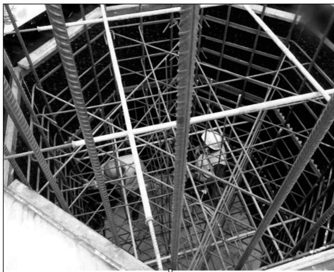
Figure 10 : Installation d'un capteur de corrosion au sein du ferrailage d'une pile
